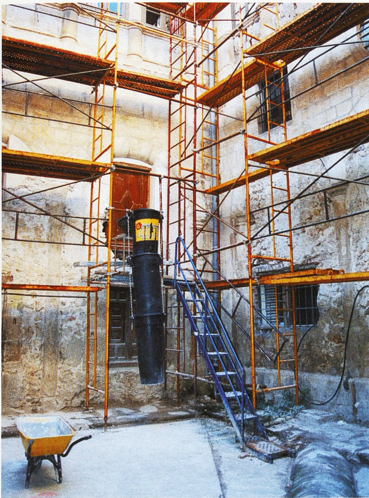
El Claustro del Palacio Episcopal se encuentra actualmente lleno de andamios. Uno de los grandes objetivos es vaciar los vanos de los arcos góticos que conforman su galería.
