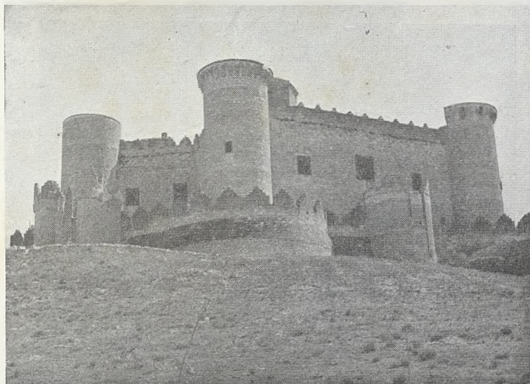
Vista general del castillo de Belmonte.
