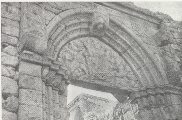
Puerta del Hospital de Peregrinos (Monterrey).
