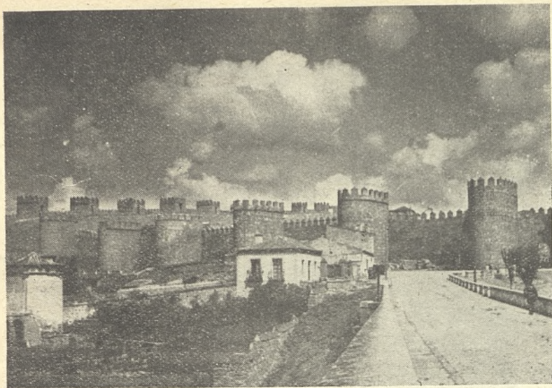
(Avila.) Las murallas vistas desde el puente sobre el río Adaja.
