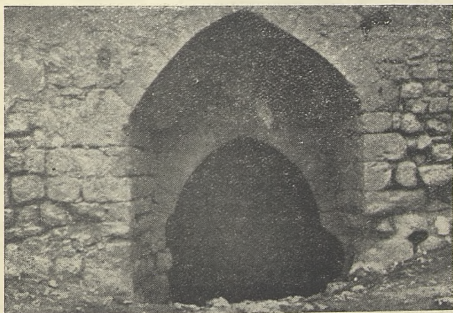
Vista de la puerta del castillo por el interior. (Fotos Villar )
