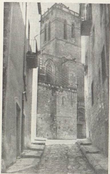
Calle de Roca, de Santa Coloma de Queralt. Al fondo, torre-campanario.
