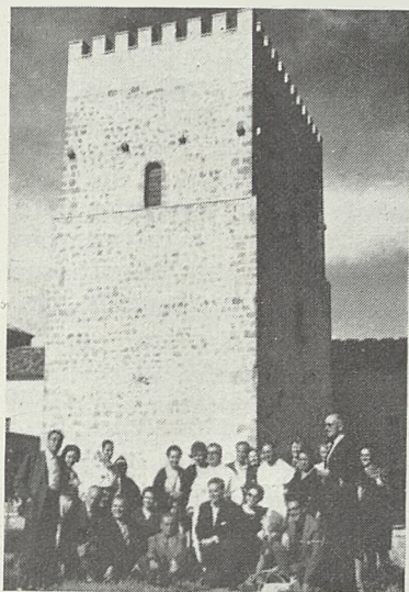
Torreón de Caleruega (Burgos)
