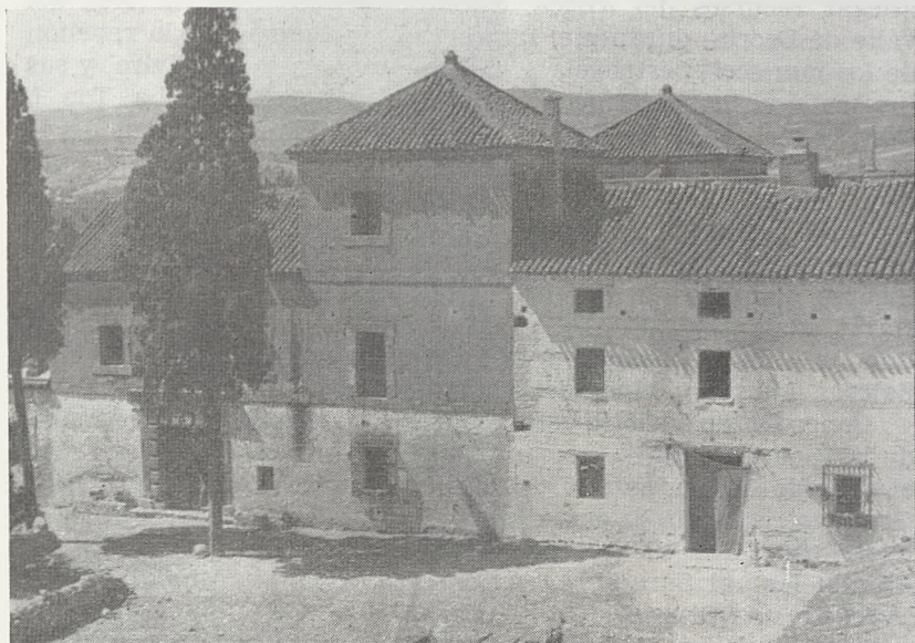
Fachada principal del transformado castillo, al que se yuxtapuso otra edificación posterior.
