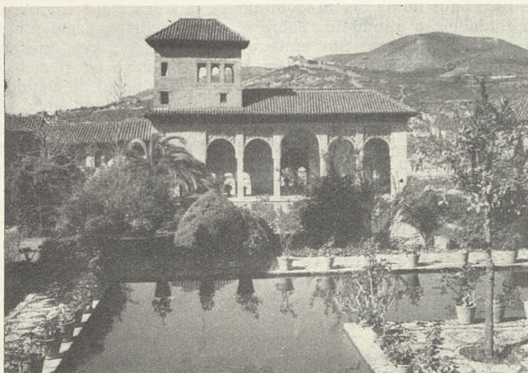
La torre de las Damas, llamada también El Portal, perdió su traza de obra militar para convertirse en risueño mirador.
