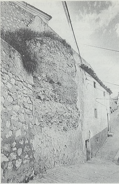
Lám. 2.—Torre de Martín Gonçalves en la calle Nueva (Muros de la Villa).
