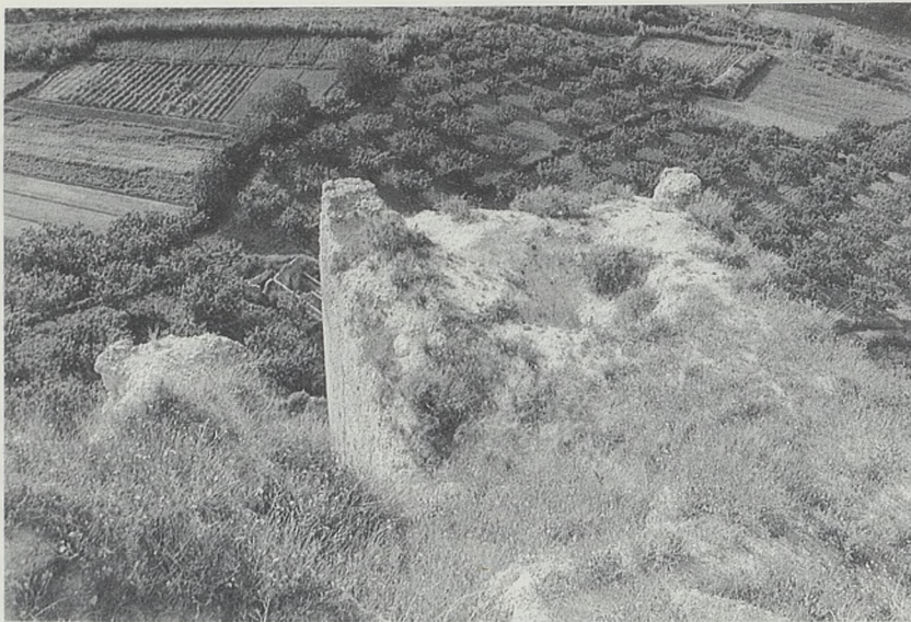
Lám. 13.—Vista del importante desnivel existente entre el fin del lienzo de la coracha y la torre de la coracha.
