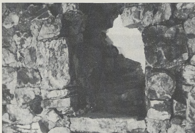
N.º 24. Detalle de la ventana que mira al sureste en dicha torre.
