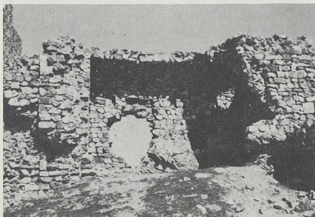
N.º 22. Interior del torreón-habitación. Véase la cortina adosada y el arranque de la bóveda de cañón que cubría la estancia existente ante él, cuyo lugar ocupa hoy la gran masa de escombros de primer plano.
