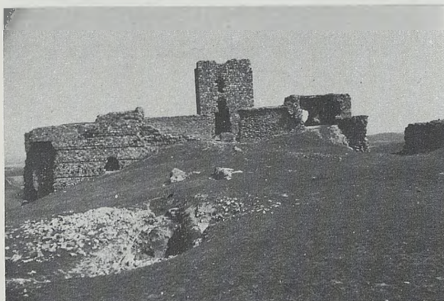
N.º 19. Vista de la cortina nordeste desde el interior de la fortaleza. En primer término el aljibe.
