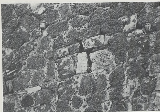
N.º 10. Detalle de la saetera derecha. Obsérvese que está cegada.
