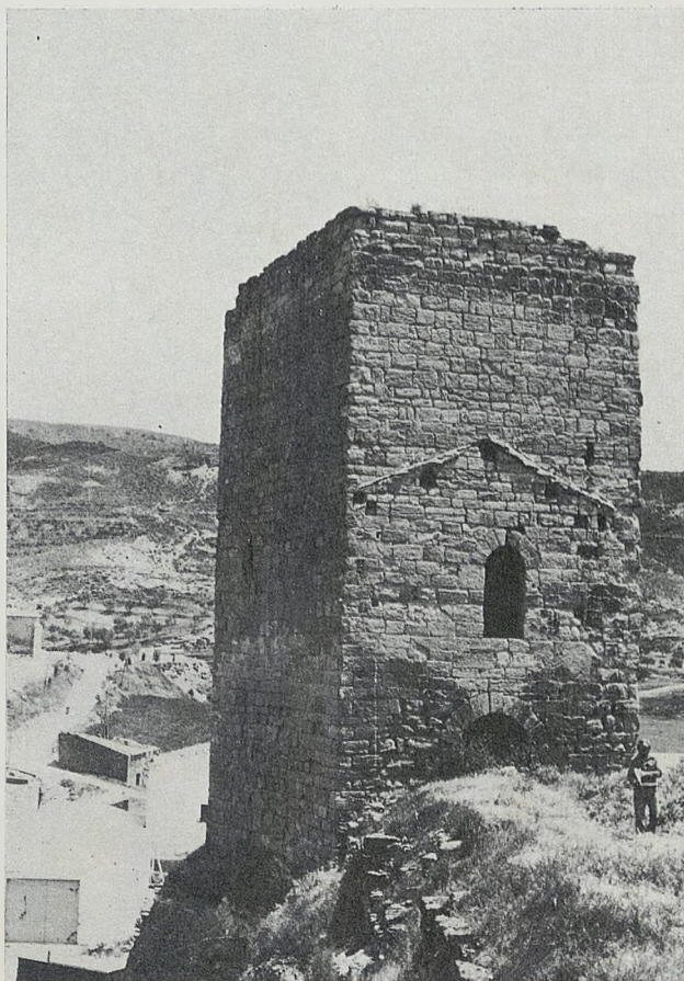
Luesia. Vista exterior por el Oeste.
