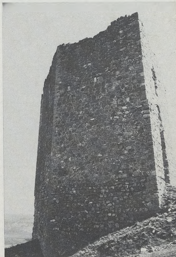
N.º 7. Cara oeste del torreón. Obsérvese el rápido declive del terreno.
