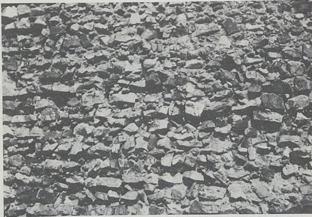
N.º 30. Detalle de la composición del muro de cal y canto.
