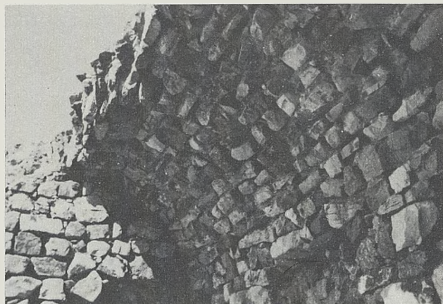
N.º 23. Detalle de la bóveda de cañón y del muro interno de dicha torre.
