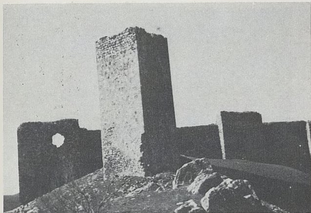
N.º 2. Vista de conjunto del frente nordeste. Destaca la poderosa torre avanzada y tras ella la cortina principal.
