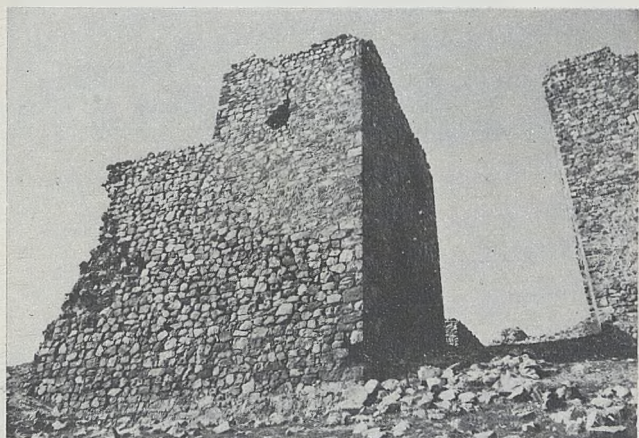
N.º 21. El mismo torreón, vista angular. Obsérvese el comienzo de la cortina sureste y el pequeño resalte existente en su base.
