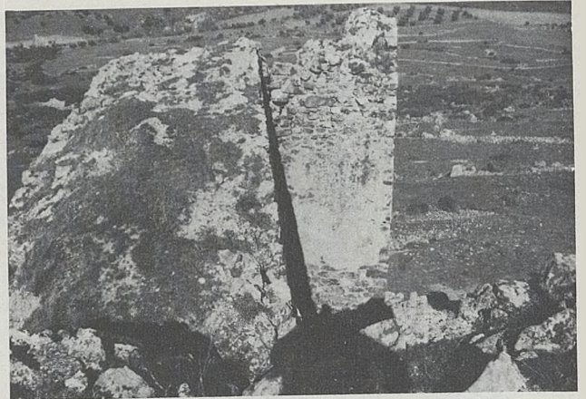
N.º 31. Vista superior de la cortina nordeste, camino de ronda y torre.
