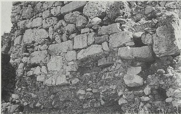
Fot. 3.- Detalle de la capa externa de sillares y rocas del cuerpo inferior macizo de la torre más dañada de las que protegen la puerta. Obsérvese la diversidad de materiales empleados.
