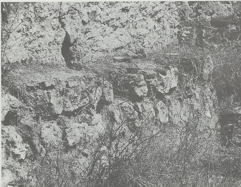
Fot. 27.- Detalle del muro existente en la parte inferior de la habitación cerca del ángulo Sudeste. Se aprecian en él los huecos para las cabezas de vigas que sostenían el techo del piso inferior. Obsérvese el nivel del suelo en 1981, colmatado.
