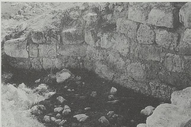
Fot. 22.- Sillares de la cara lateral Sur y del espolón de la torre pentagonal Norte. Vista interna. Obsérvese la colocación a soga y tizón sin orden determinado, típicamente califal.
