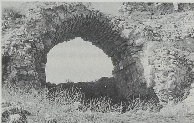
Fot. 5.- Vista de la entrada desde el interior del Castillo. Se ven los sillares de sus muros y la masa de hormigón que formaba el cuerpo macizo de las torres. En el ángulo superior las dos ventanas de la habitación de la guardia.
