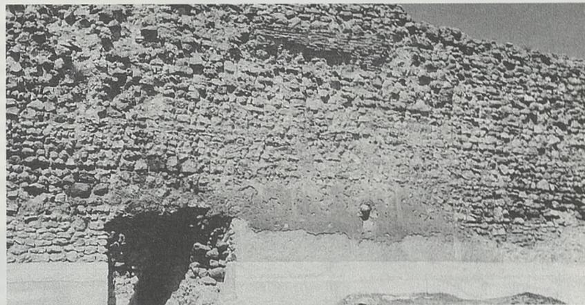
Fot. 16.- Detalle de la cortina Sur tras la torre albarra más dañada. Obsérvese el tramo de ladrillo base de uno de los lados del puente de paso. Hay 13 hiladas de ladrillo.
