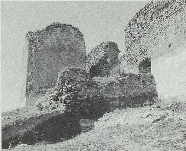
Fot. 12.- Vista de los restos de las dos torres albarranas ante la cortina Sur. En la cortina se aprecia el hundimiento central.
