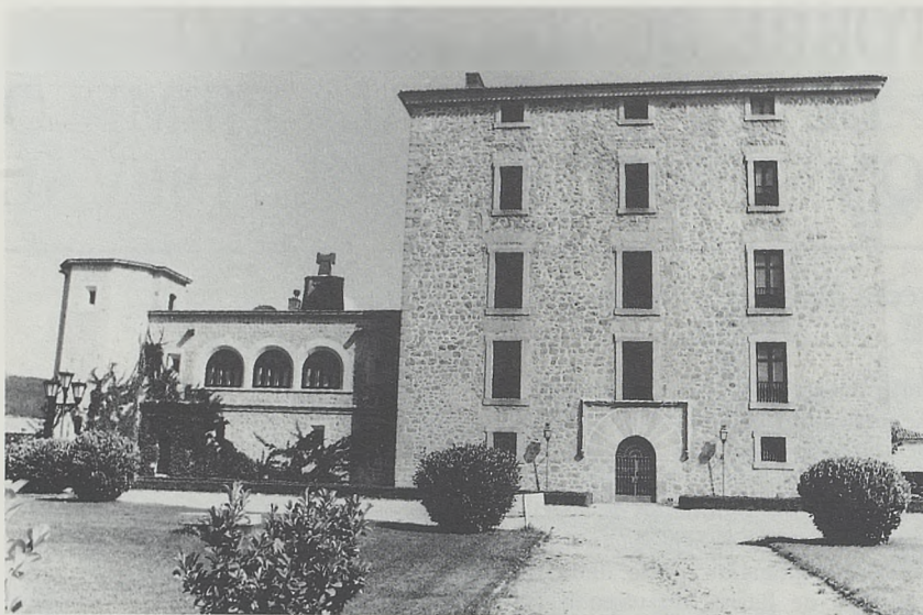
Fachada delantera (sur) de la casa-torre con el anexo neogótico de los años 50.
