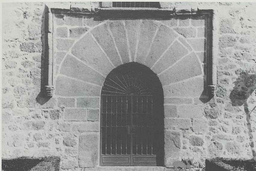
Puerta delantera de la casa-torre. Corresponde a la edificación del siglo XIV.
