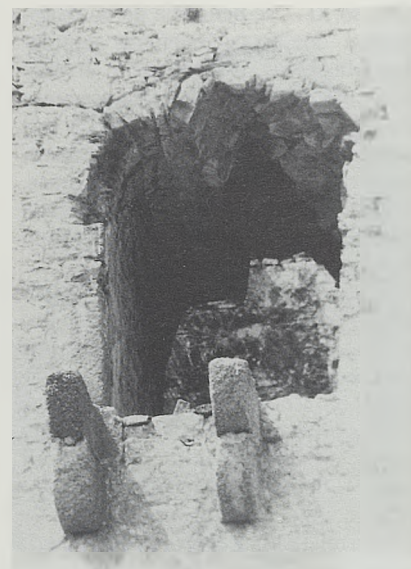
Ventanal con matacanes en la planta superior de la torre del homenaje.
