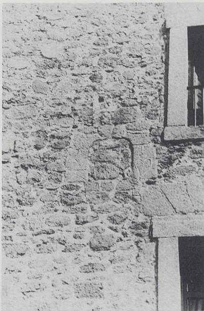
Vano cegado en la fachada delantera correspondiente a la edificación del siglo XIV (símbolo de cantero en el lado derecho).
