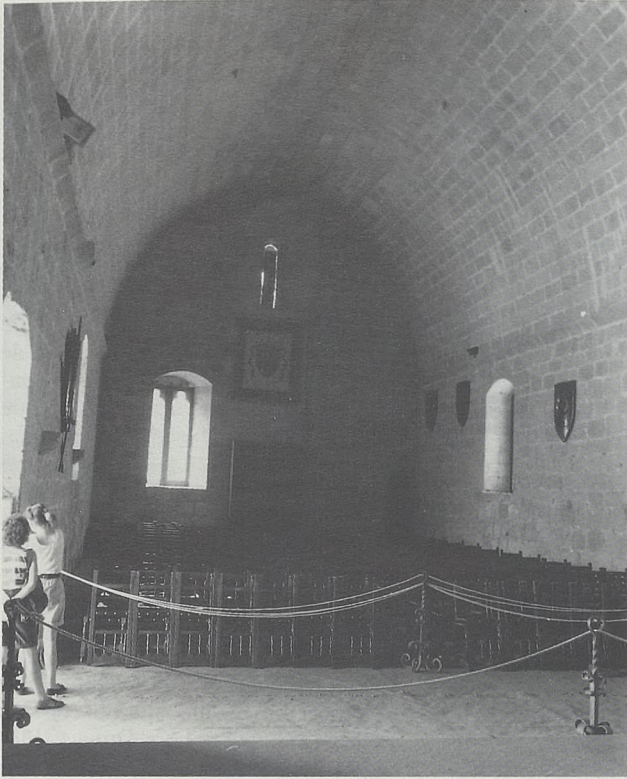
Fot. 5.—Miravet, interior de la capilla de San Miguel (fot. J. F.).
