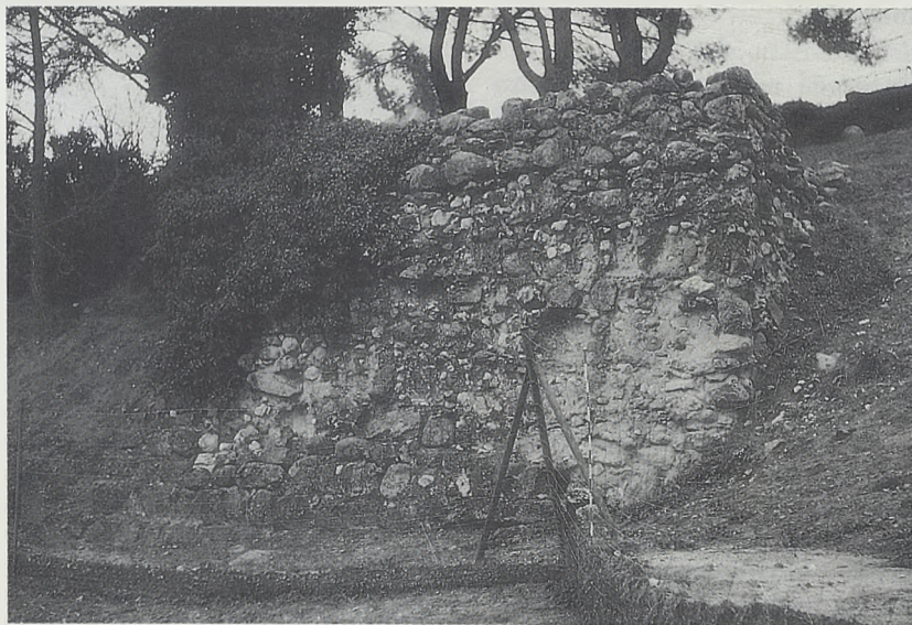
Fig. 10. Vista frontal de uno de los torreones de Alamín.
