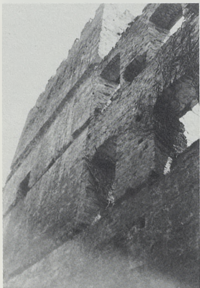
Interior de los muros de la zona residencial coronado por la torre del homenaje.
