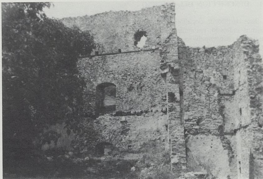
Vista interior de la torre norte.
