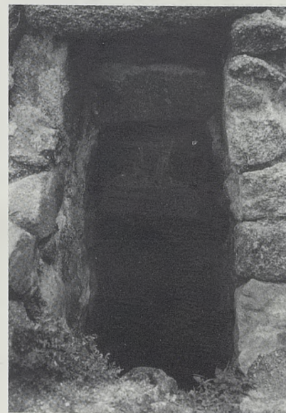
Fig. 10. Entrada a la galería embutida
