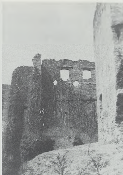
Vista parcial de la zona destinada a residencia.
