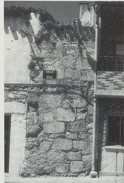
Fig. 9. Único resto visible de la muralla. Cadalso de los Vidrios.
