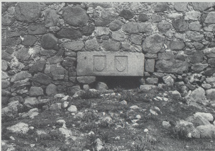
Fig. 5. Puerta de acceso a la torre en el lateral Sureste, 1988
