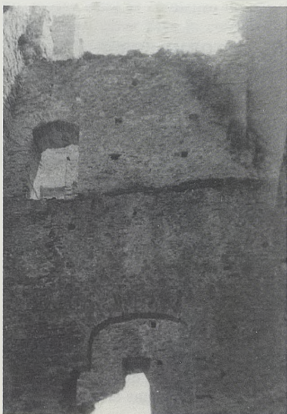
Interior de la torre de acceso.
