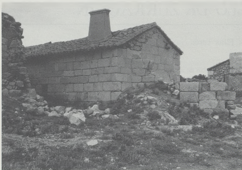
Fig. 2. Construcción de sillares en la parte trasera de la torre
