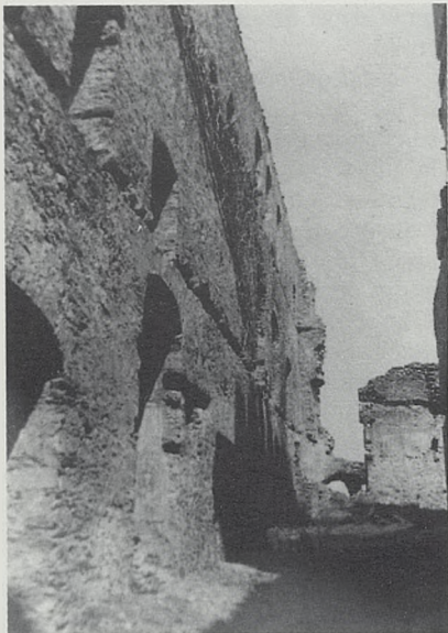
Interior de los muros de la zona residencial.
