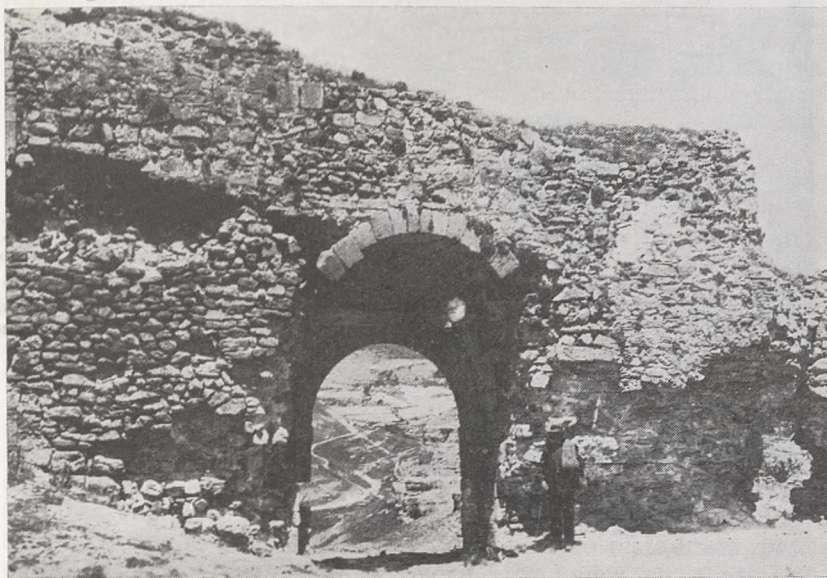
La puerta «de la Fuerza», antes de su restauración.
