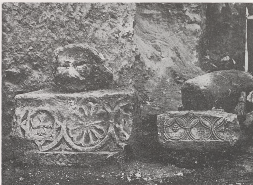
Restos de construcciones visigodas y árabes aparecidos durante las obras efectuadas en la puerta de Alcántara.
