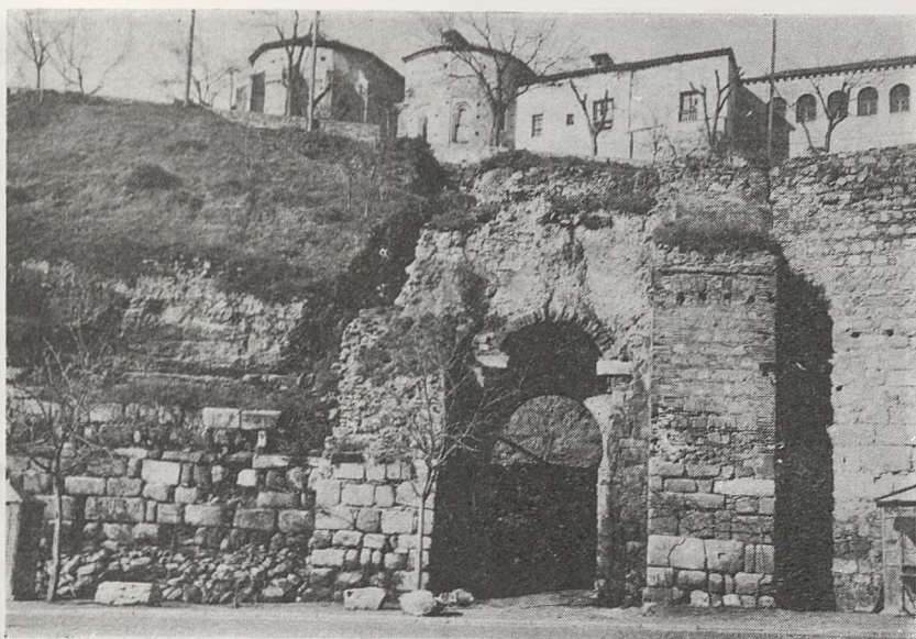
Estado de la puerta de Alcántara antes de su reconstrucción.
