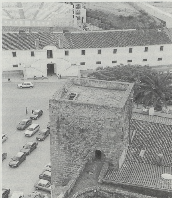
Fig. 9 La torre albarrana desde la torre del homenaje.
