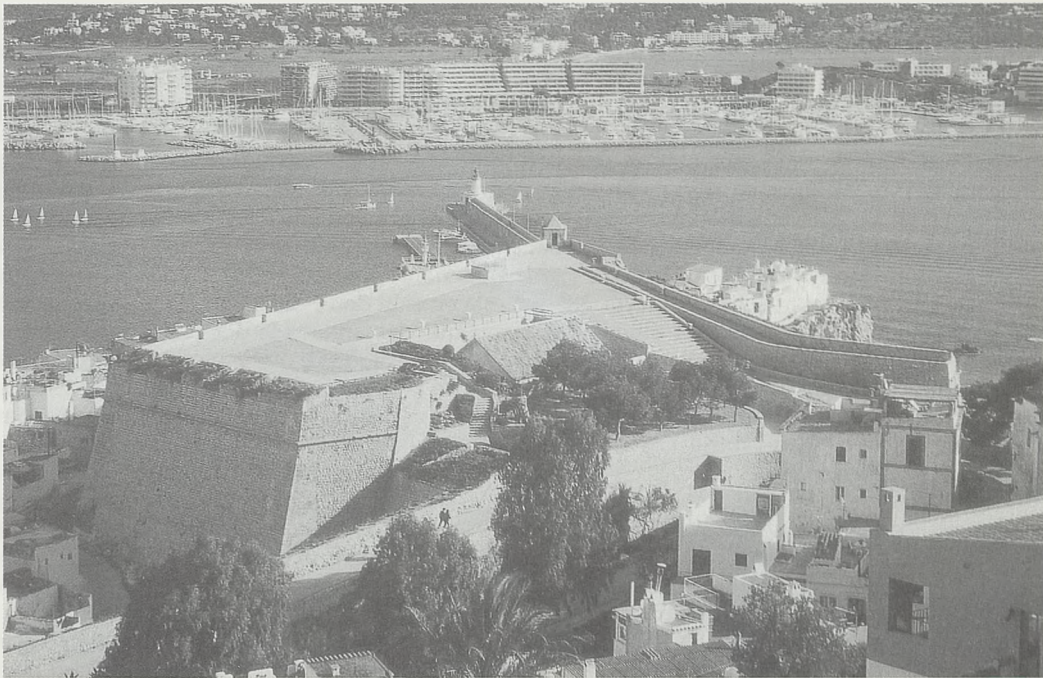
Ibiza, baluarte de Santa Lucía, corresponde a la ampliación del Fratirn
