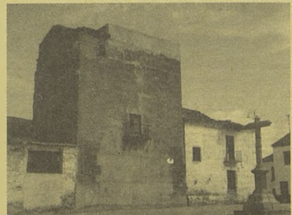
Vista de la torre
