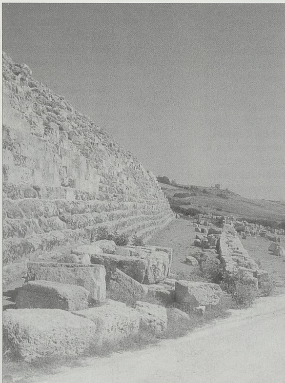
Selinunte: frente Este. Muralla principal con zarpas y restos de la barrera
