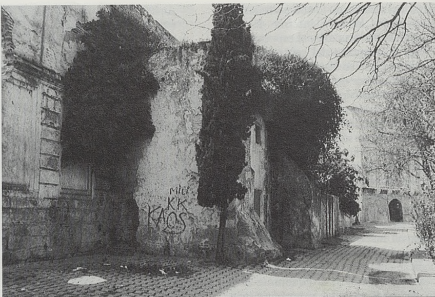
Torre-puerta del lienzo del río, desde el exterior.
