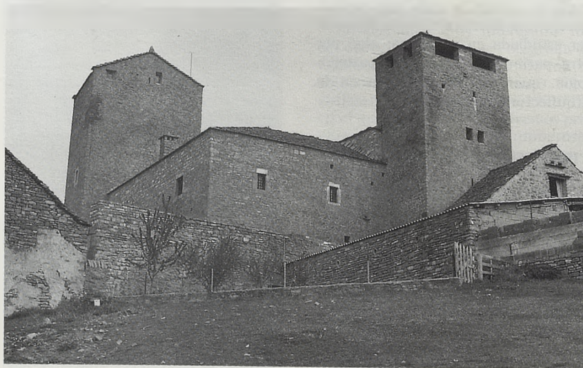
Larrés: Vista general desde el sureste.
