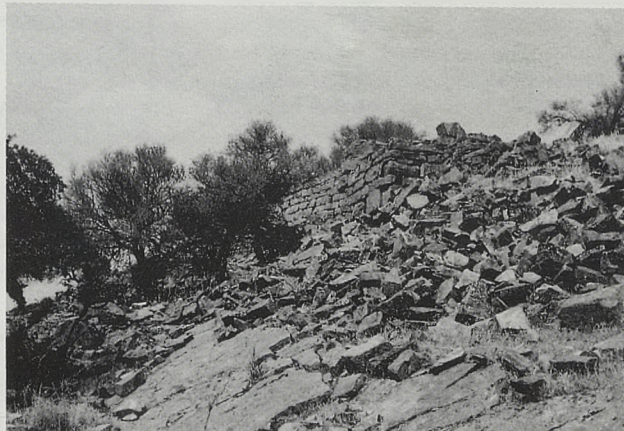
Detalle de los restos de cortina del recinto principal. Se ve la roca de pizarra sobre la que se levantaba.
