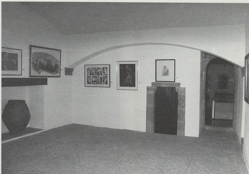
Larrés: Planta noble de la torre grande. A la derecha, puerta de ingreso a la escalera intramural que sube a la planta superior. Junto a ella la puerta que da a la escalera, de medio punto. La tercera puerta, en el centro, corresponde a la escalera intramural que procede de la planta baja. A la izquierda, el hogar.
