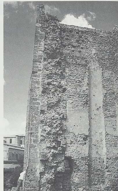
Foto 2. Torre gótica del alcázar. En la fractura se aprecia como apoya sobre el lienzo de sillares islámicos que debía tener aquí casi toda su altura original.
