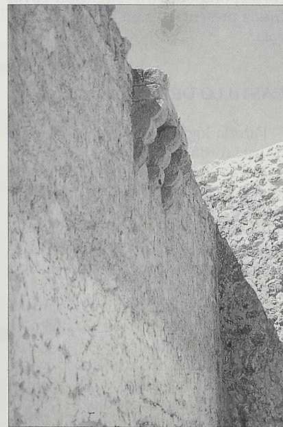
Restos de matacanes existentes en la cortina principal del castillo de Peñarroya. (Argamasilla de Alba, Ciudad Real.)
