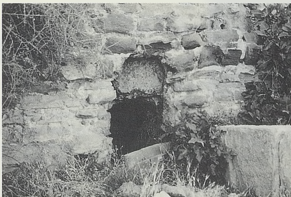
Almedina, Pasadizo que lleva al interior de la ciudad. Por él aflora el manantial que surtía de agua a los pobladores
