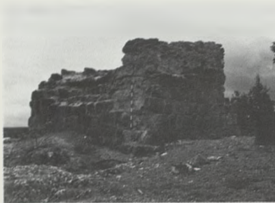
Lám. 13.1. Torre de Vadorrey. Lado NO.
