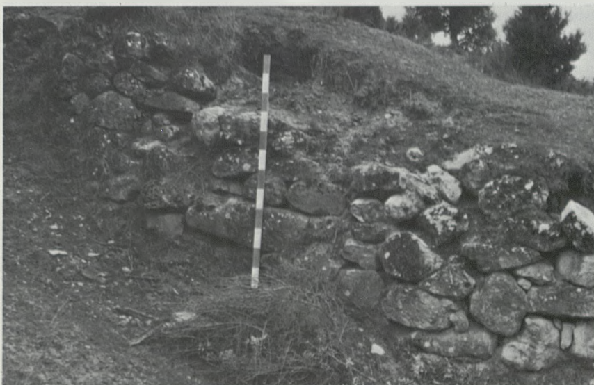
Lám. 12.2. Vadorrey. Detalle de la muralla.
