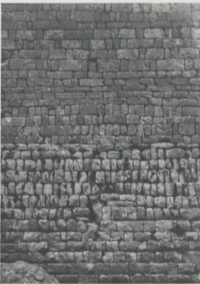
Lám. 5.2. Castillo de Gormaz. Detalle del muro O.
