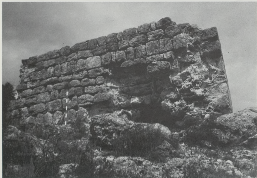
Lám. 13.2. Torre de Vadorrey. Lado S.
