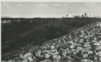
Lám. 1.1. La Villavieja. Lado O de la muralla con Medinaceli al fondo.
