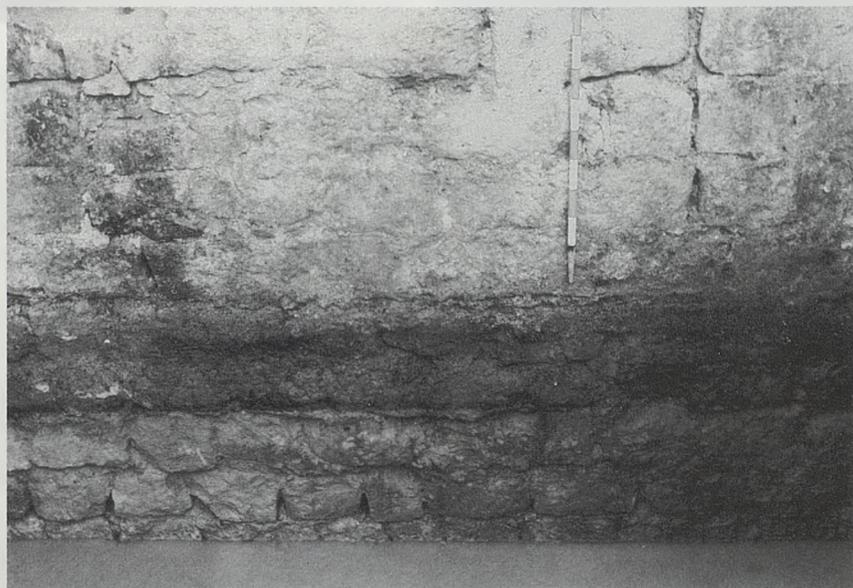
*Paramento de la muralla bajomedieval, en donde se aprecia claramente una primera fábrica de sillares más menudos (hasta el jalón), y otra fábrica de sillares de módulo mayor (donde está el jalón).*
