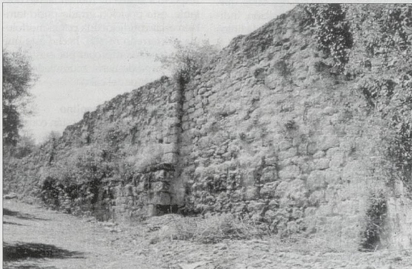
Cara externa del acueducto del Molino del Cubo en la que se aprecian las distintas reparaciones que ha tenido a lo largo de su historia
