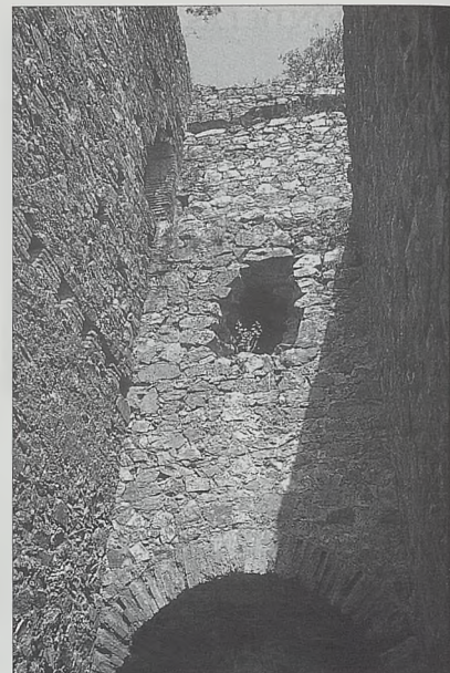
Herrera del Duque. Frente este de la cámara tras la entrada, se aprecian los mechinales de los suelos de la 2ª planta y la comunicación con la cámara de la buehedera.
