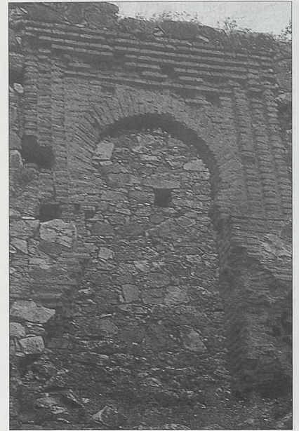
Herrera del Duque. Entrada a la planta principal del palacio.
