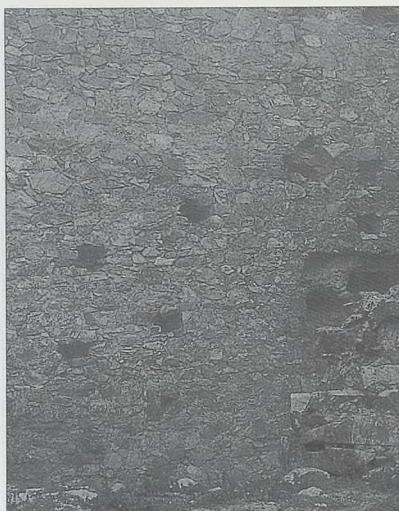
Herrera del Duque. Huecos para las vigas de la escalera del palacio.
