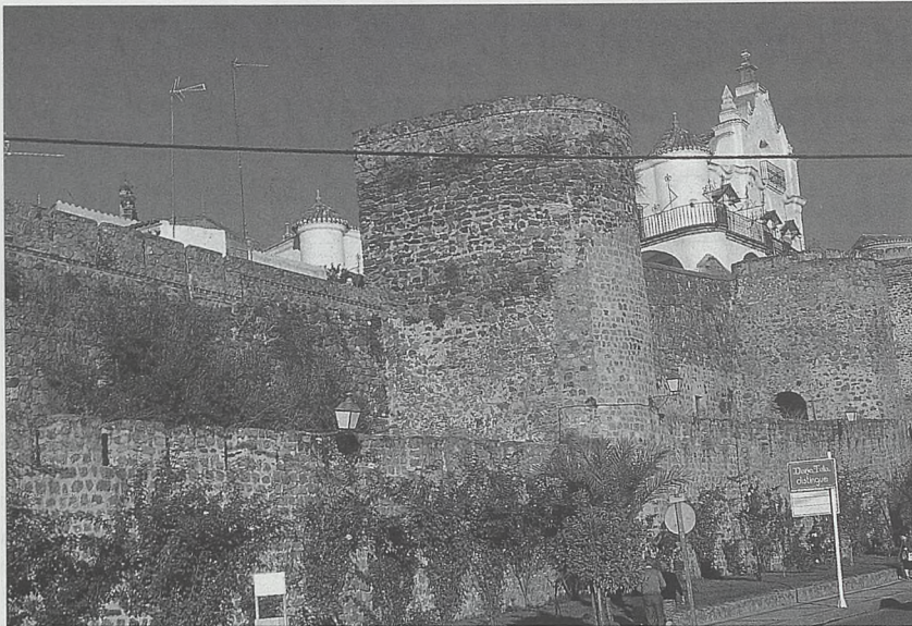
Murallas de Plasencia. Cáceres.*
