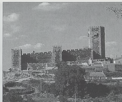
Fortaleza de Sabugal. (Portugal).*
