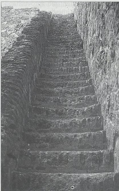
La Puebla de Alcocer. La gran escalera a los adarves del recinto este.
