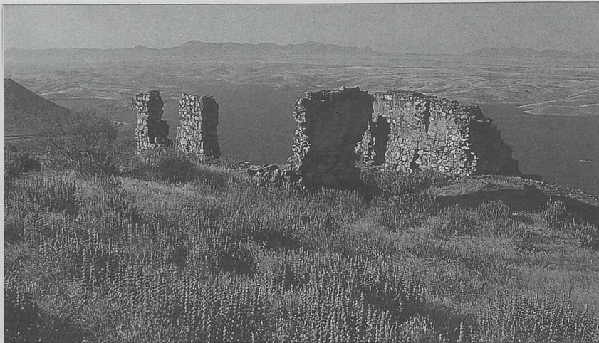
Vista de la ermita desde el interior del castillo. A la izquierda se observa el cerro Masatrigo convertido en península por el embalse; a sus pies se juntaban el Guadamar y el Zújar. Se aprecia el dominio del Peñón sobre La Serena y al fondo la sierra del Torozo donde se ubican los castillos de Garlitos y Capilla.
