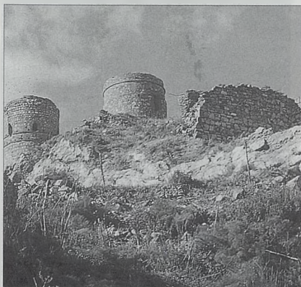
Castillo de Capilla. En primer término muros del recinto antiguo.
