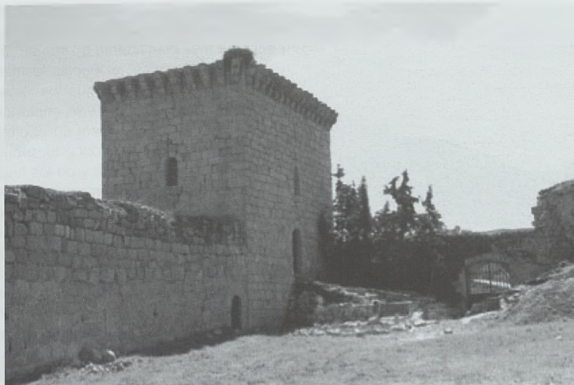
Torre del Homenaje vista desde el Noroeste. A pesar de los vanos con arcos de medio punto hay un claro predominio del macizo sobre el vacío
