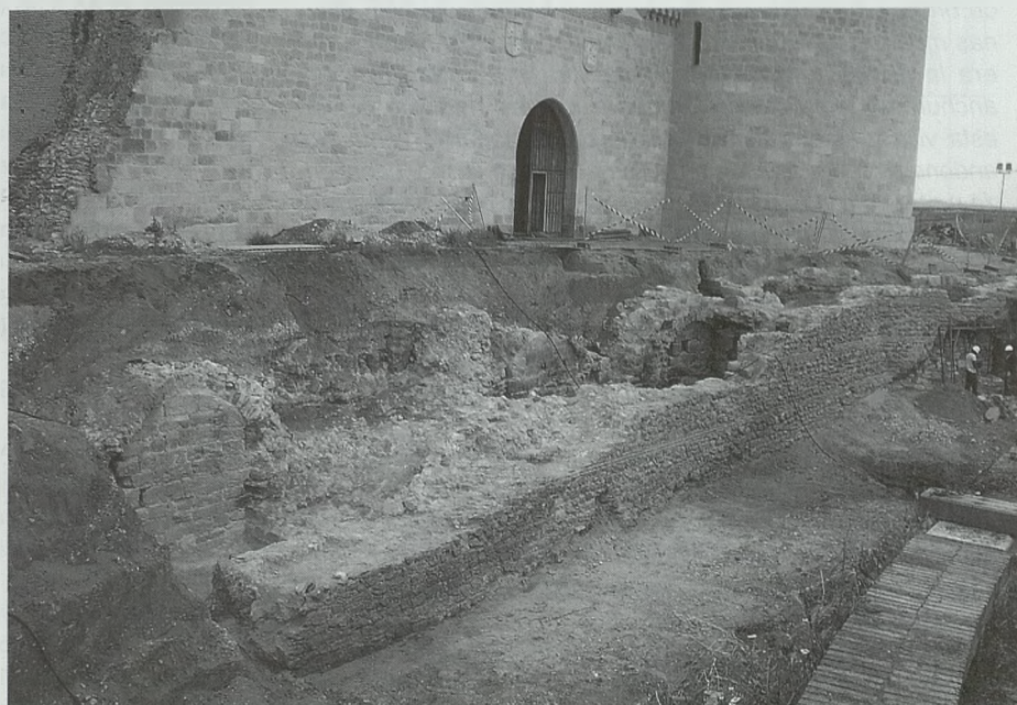
Fig. 12. Imagen del proceso de excavación del frente del castillo
