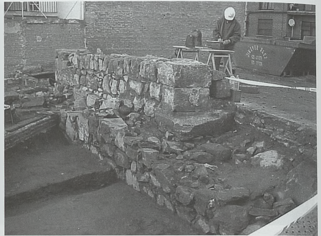
Cimentación en el edificio de los Nuevos Juzgados
