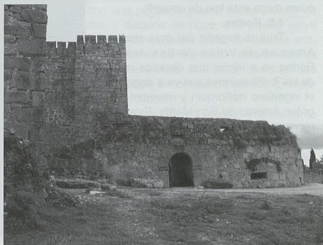
Puerta de acceso del baluarte de Trujillo
