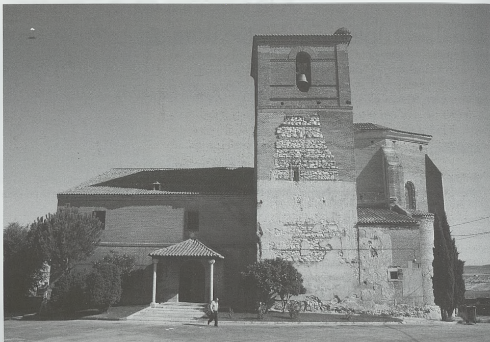
Figura 2. Iglesia de Sinlabajos
