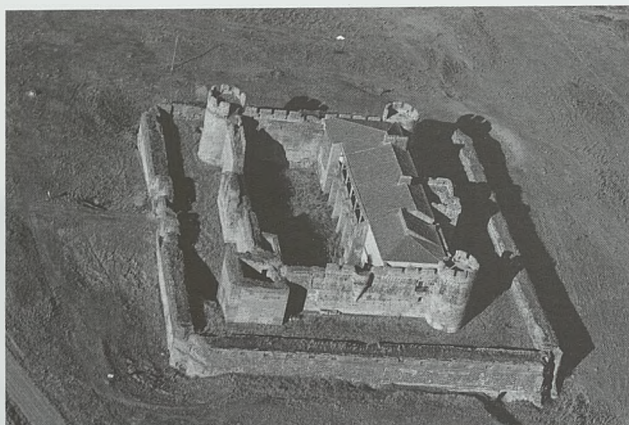
Castronuevo desde el aire. Se aprecian los huecos semicirculares de los cubos esquineros no realizados
