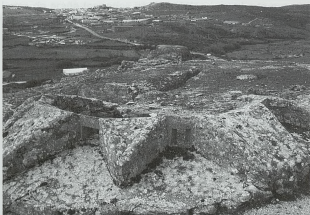
Posición «Carretera» al este de las Navas del Marqués. Se aprecia el parapeto con troneras prefabricadas y el nido blindado semiesférico al fondo
