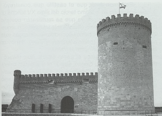
Fig. 2. La parte de sillería con la tronera de orbe y palo corresponde con la obra del Duque de Arévalo
