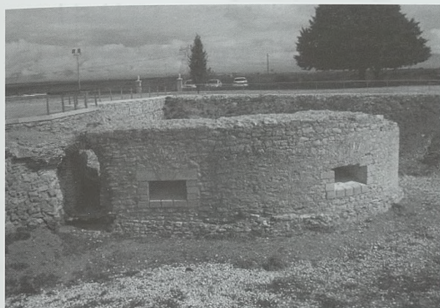
Poterna del baluarte de Arévalo
