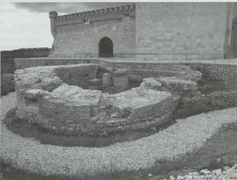
Fig. 9. La presencia de troneras en la parte baja del baluarte permitió la defensa del lecho del foso, que tradicionalmente quedaba indefenso
