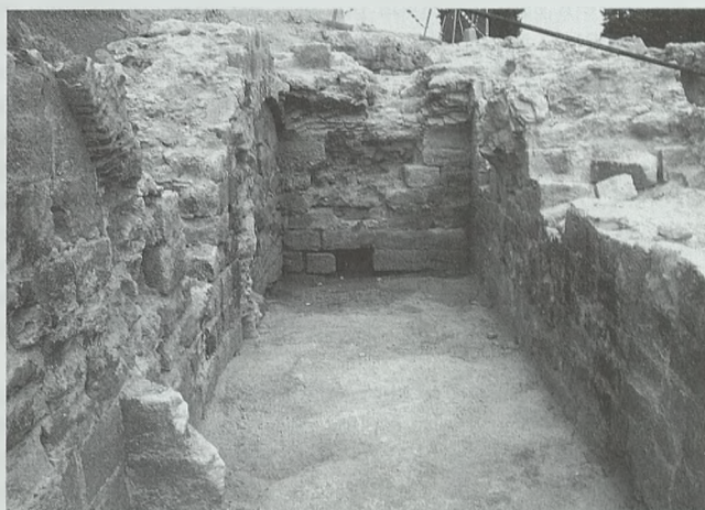
Fig. 3. Conjunto de tres cámaras de tiro. En una fase posterior, se tapiaron las troneras y se eliminan los muros divisorios, quedando un espacio diáfano sin aberturas que se utilizaría seguramente como almacén
