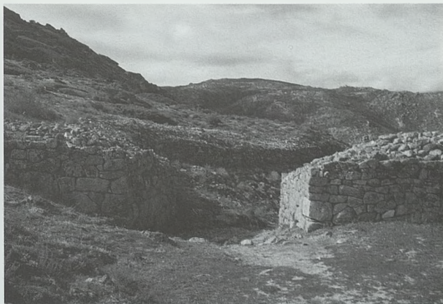
Vista general de la muralla y de la entrada oeste de Ulaca
