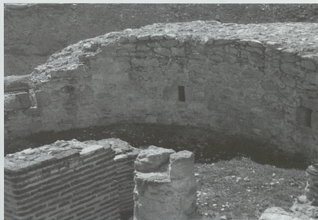
Cañoneras interiores del baluarte de Arévalo
