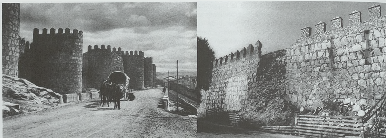
Derrumbe en cubos y lienzos
