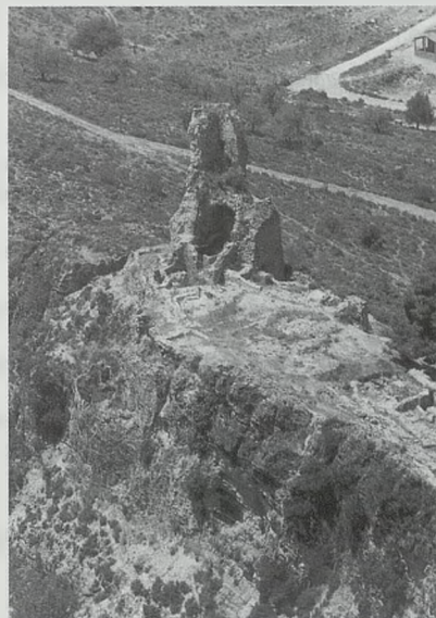
Vista del castillo antes de su intervención (Fotografía de archivo de la UPV)
