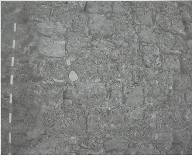
Fig. 5 Detalle de la fábrica Mampostería 2
