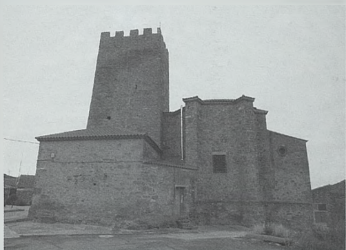
Iglesia fortificada de Trébago
