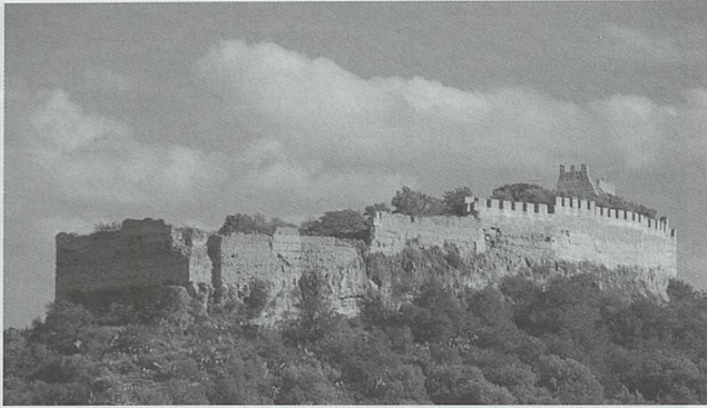
Castillo de Corbera desde la parte oeste (Foto M. Gómez)
