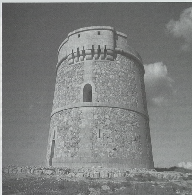
Torre de Alcaufar. Vista general, tras la restauración Autor: Antonio Amilcar Seguí Prieto
