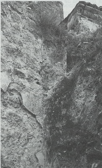
Fig. 6 Detalle del muro de tapial
