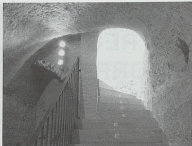
Torre Torrent. Escalera interior, estado actual (Fotografía de archivo de la UPV)
