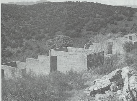
Viviendas modulares en el campamento de La Peña (Navalagamella, Madrid)
