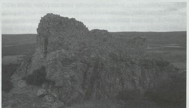
Detalle de paramentos exteriores de la fortaleza. Al fondo el valle del río Villanueva
