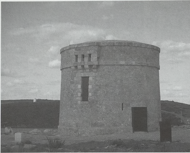
Torre Teulera. Vista general, tras la restauración. Autor: Antonio Amilcar Seguí Prieto
