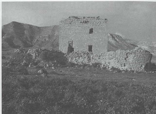
Torre Fuerte o de los Alumbres de Rodalquilar desde el sur
