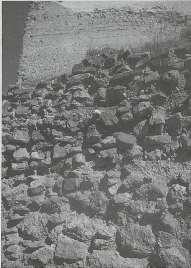
Liengo del castillo realizado mediante mampostería trabada (Fotografía de archivo de la UPV)
