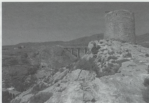
La torre de La Garrofa, hacia 2005, antes de su restauración
