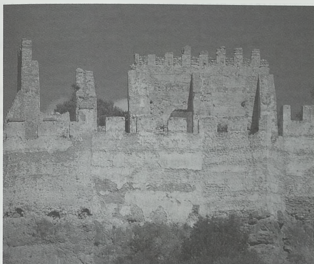
Los contrafuertes para reforzar los muros de la casa gótica situada en la celoquia y la muralla principal reconstruida del castillo de Corbera en la zona sur-oeste (Foto M. Gómez)
