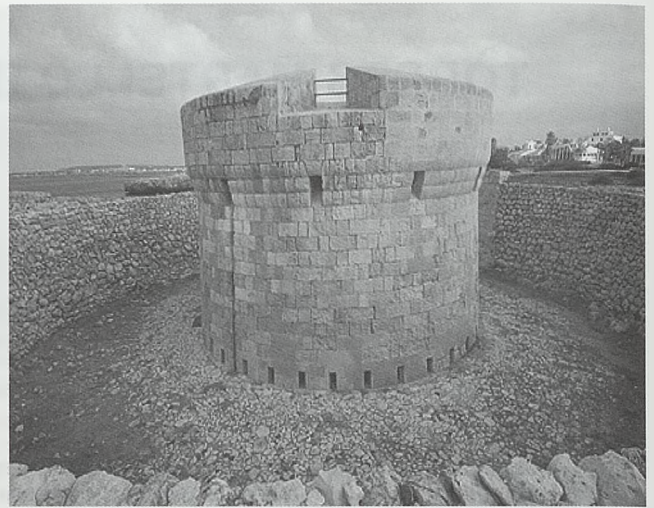
Torre de Santandria. Vista general
