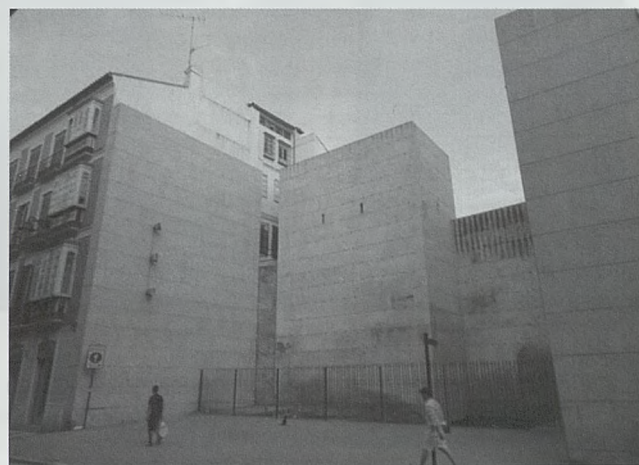
Muralla de la Málaga nazari de la calle Carretería
