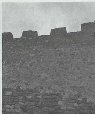
Muro del castillo realizado la parte inferior con mampostería y la superior con tapial (Fotografía de archivo de la UPV)
