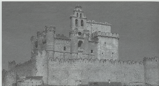
Vista de la fachada meridional del castillo
