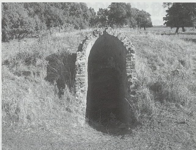
Una de las entradas al refugio antibombas del aeródromo de Benquerencia
