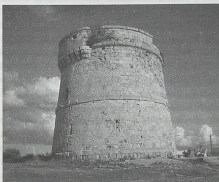
Torre de Punta Prima. Vista general, tras la restauración. Autor: Antonio A. Seguí Prieto
