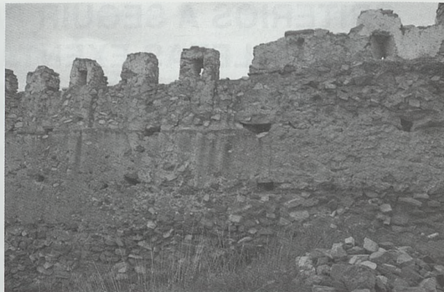
Foto del muro interior Norte, donde se observan los módulos y los agujeros dejados por las agujas inferiores (Fotografía de archivo de la UPV)
