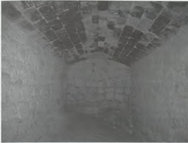
Bóveda de la planta inferior de la Torre Fuerte o de los Alumbres de Rodalquilar
