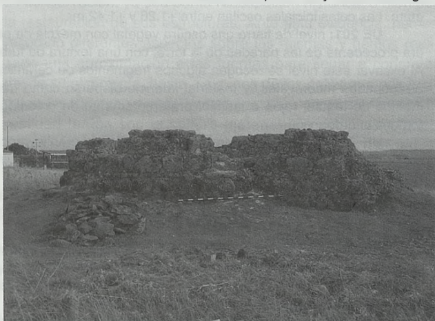
Aspecto de la torre en el proceso de limpieza (Foto L. Arcos)
