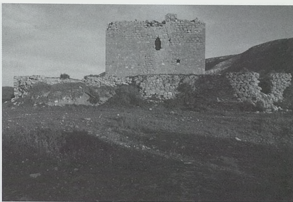
Torre Fuerte o de los Alumbres de Rodalquilar, desde el Oeste
