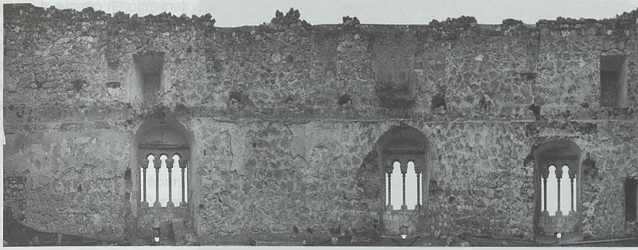
Fig. 4 Rectificación fotográfica del alzado interior noroeste
