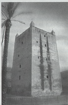
Torre Torrent. estado anterior a la restauración (Fotografía de archivo de la UPV)
