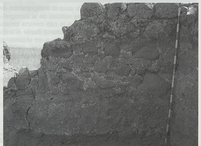
Detalle de la fábrica de los muros en el interior de la torre
