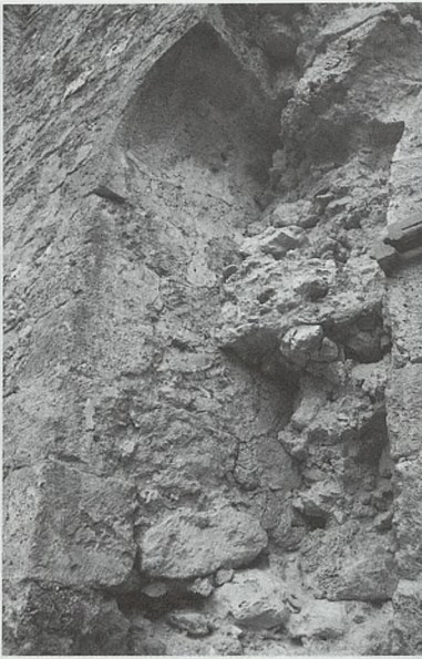
Fig. 8 Vestigios de un vano seccionado por la construcción de acceso a la capilla
