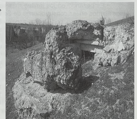
Fortín emplazado en el cerco a la bolsa nacional de la estación de tren de Las Rozas
