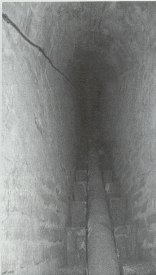
Interior del pasadizo que, desde la muralla sudoeste, permitía una salida de escape hacia el Guadalquivir
