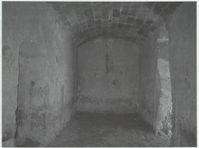
Bóveda de la planta principal de la Torre Fuerte o de los Alumbres de Rodalquilar
