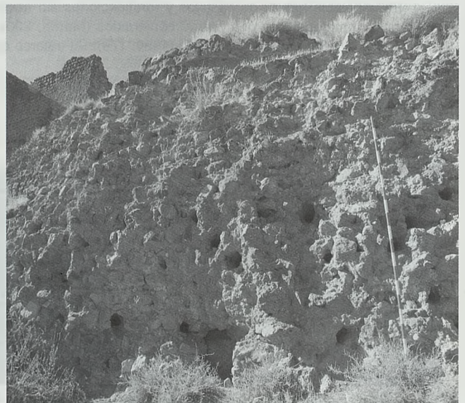
Fig. 7 Toma del frente del L13, realizado en Tapial 3
