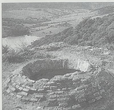
Extradós de la bóveda de la estancia superior de la torre de Botafuego, que aflora en el terrado.
