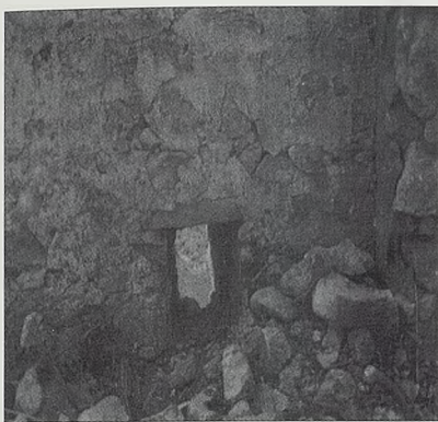
Parte del lienzo amurallado que presenta pequeñas aperturas.
