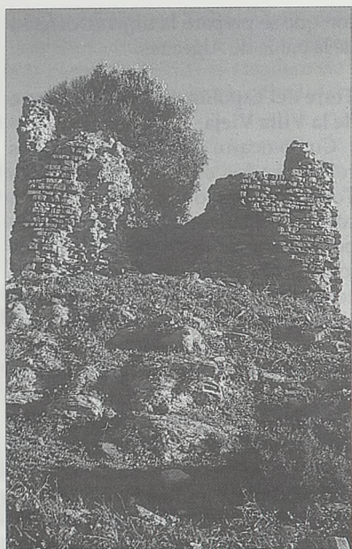
La torre del Arroyo del Lobo, sobre la ensenada de Getares, «se corresponde mal con la marina».
