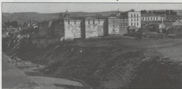
Guadalajara. Cuartel de San Carlos. Fachadas norte y este. Jean Laurent, c. 1873.
