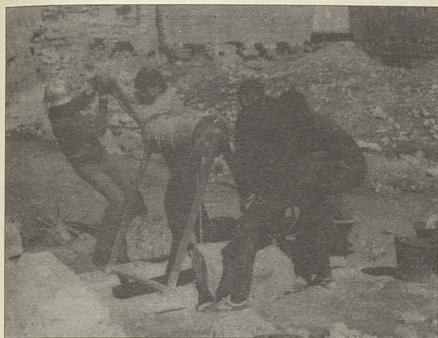
Desescombrando el pozo, todos trabajaban con ilusión
