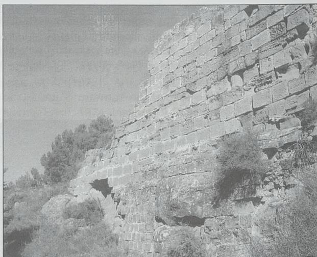
*Vista próxima de la estructura de las dos tomas superiores. Detalle de la cimentación sobre roca natural y de dos elementos constructivos distintos (sillares diferentes de la parte superior e inferior)*
