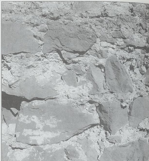
Obra general del interior de los muros del castillo: mampuestos ligados con argamasa (cal, cantos rodados y esquirlas de la mtalla de los mampuestos)
