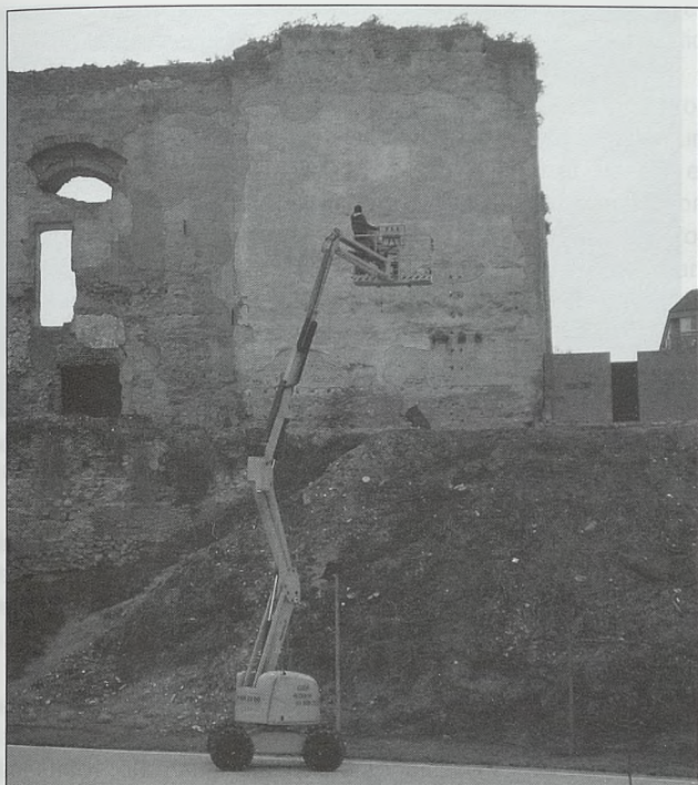
Guadalajara, Alcázar Real. Trabajos de fotogrametría en la fachada oriental, 2005
