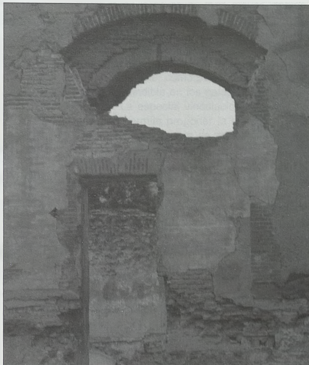
Vista desde el exterior del palacio del mirador de la alhania oriental del salón principal, supuesta obra de Alfonso XI. El vano adintelado de ladrillo corresponde a la fábrica del siglo XVIII
