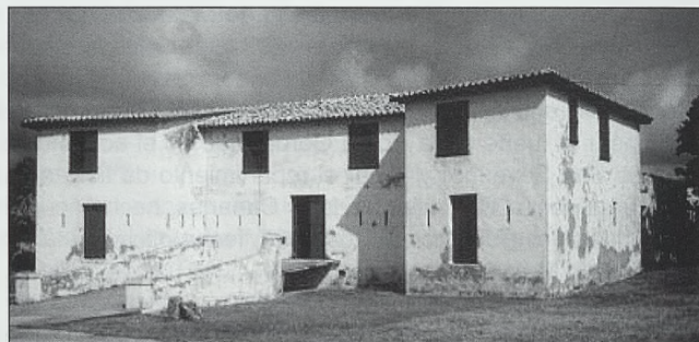
Casa-Fuerte aspillerada de la batería el Morrillo
