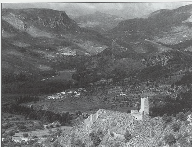
Llano de la Torre. Vista general
