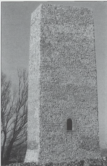
Torre de Masegoso (Soria) -hoy despoblado-, tiene una altura de 18 metros
