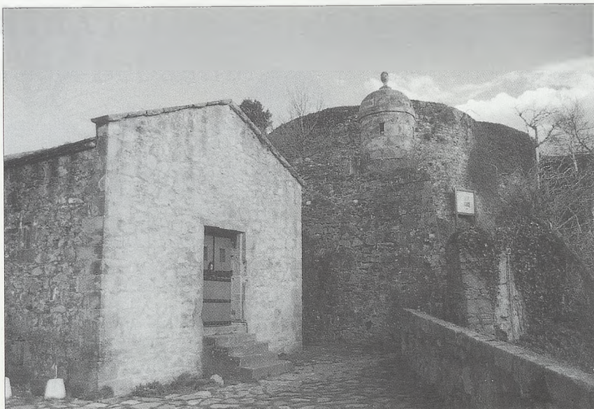
En primer plano, el polvorín de la batería de San Antonio, detrás, la batería de Santa Clara Alta y al fondo, la batería de Santiago.
