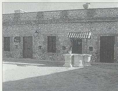
El brocal del aljibe y los vanos de las dependencias.
