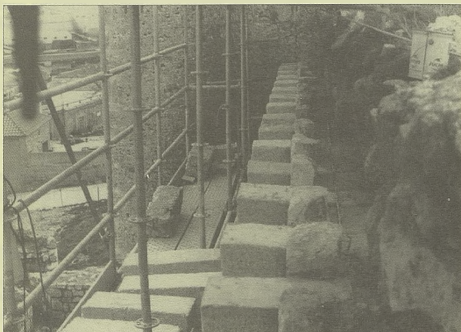
Fachada norte en proceso de restauración.
