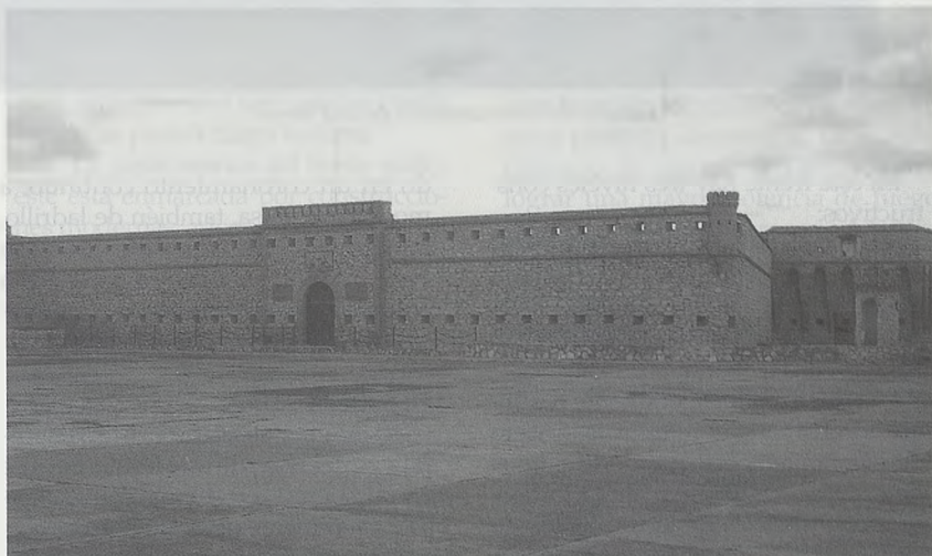
Vista del frente del fuerte de Cabrerizas Altas. (Melilla).
