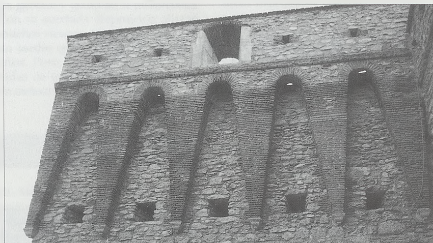
Detalle del coronamiento de una torre
