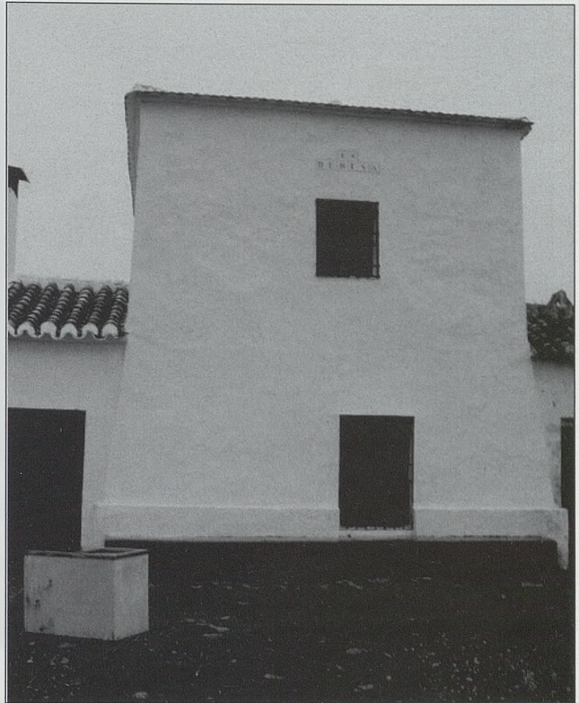
La Casa de la Dehesa, en Carrión de Calatrava
