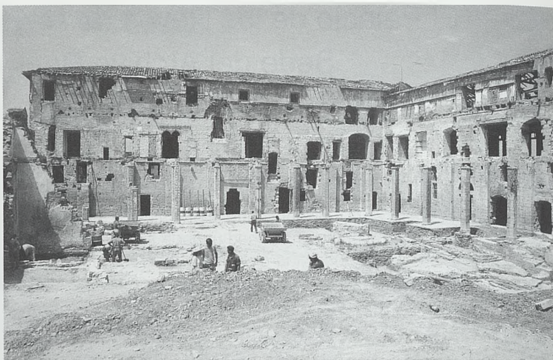
El antiguo palacio medieval, en la fase de eliminación de añadidos posteriores
