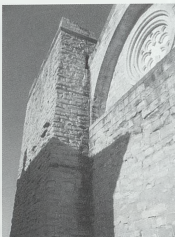
Exterior de la torre sudoccidental superviviente y hastial de la iglesia con óculo calado. Autor Julia Baldó
