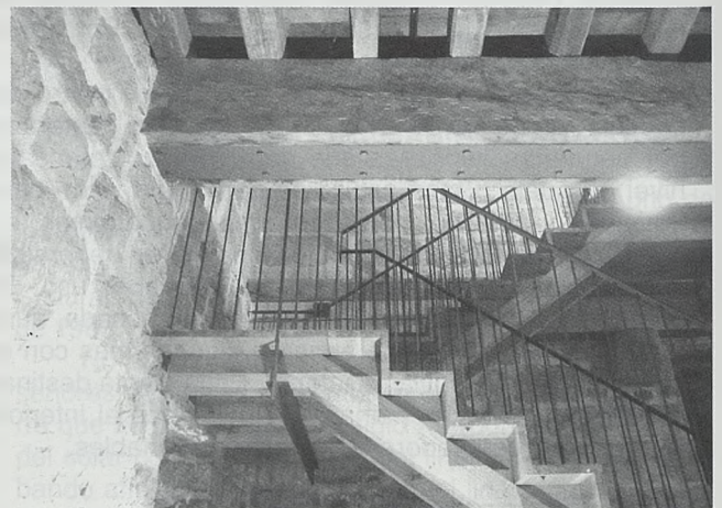
Estructura de la escalera
