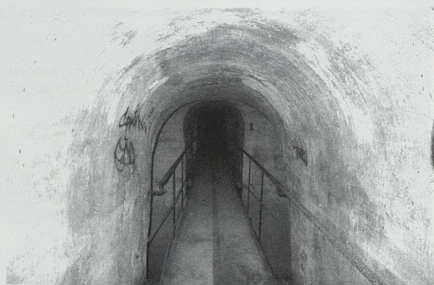
Acceso a los aljibes para almacenamiento de agua (Foto J.V. Valdenebro)
