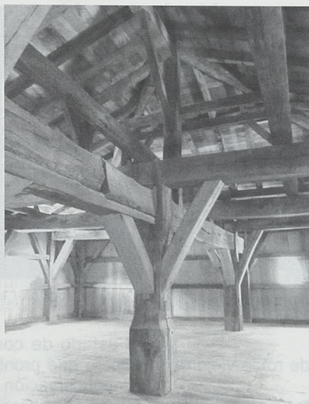
Estructura interior del cadalso
