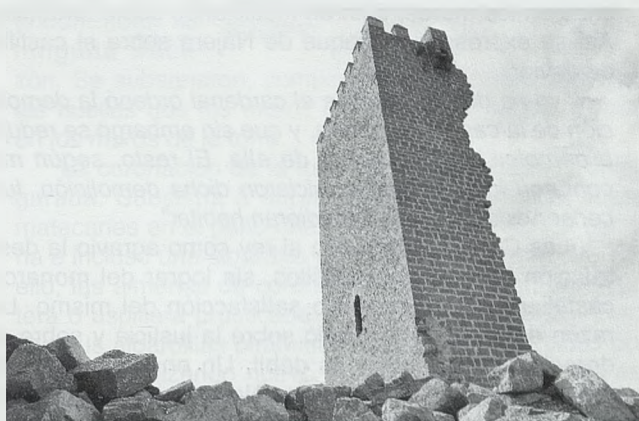
Imagen de la torre del Homenaje del castillo de Santacara en 2010, tras las obras de consolidación
