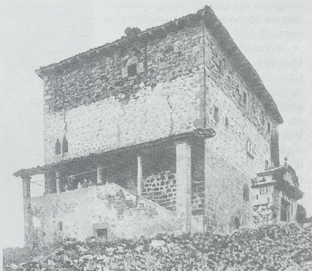
Torre de Jaureguizar a principios del siglo XX. Se aprecia aún, hacia la derecha, parte del recinto exterior y el arco de entrada al mismo
