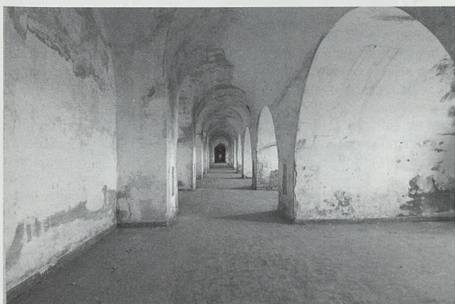
Pasillo de circulación de las casamatas (Foto J.V. Valdenebro)
