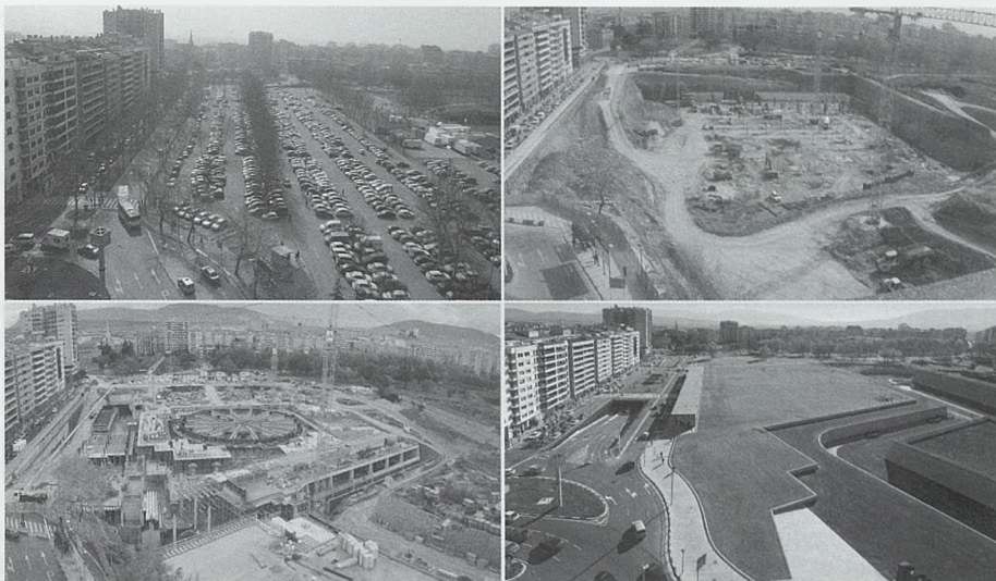
Nueva estación de autobuses y recuperación del Revellín de Santa Lucía de la ciudadela de Pamplona
