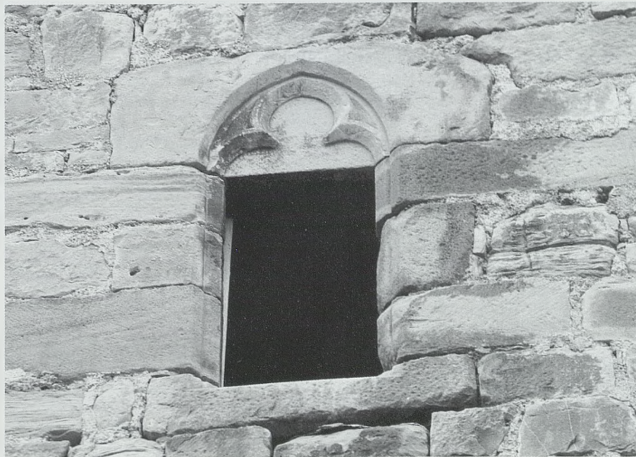
Fig. 7. Palacio de Equisoain: ventana alta de la torre
