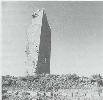
Imagen de la torre del Homenaje del casti- llo de Santacara, tras las obras de la segunda intervención
