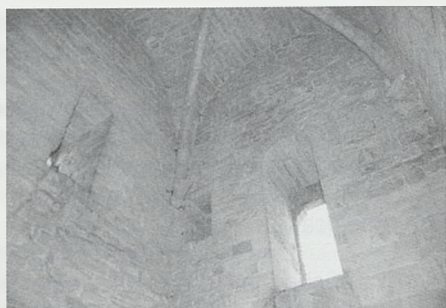
Interior de la torre sudoccidental superviviente. Primer piso y bóveda. Ventana saetera al oeste y al norte, puerta de comunicación con el primer piso del ala occidental del monasterio. Autor Javier Martínez de Aguirre
