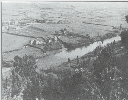
Figura 14. Uso de la fotografía antigua para identificar elementos. Antigua Torre de Bustamante en Santiago de Cartes, citada en 1627 como «una torre fuerte, al parecer muy antigua, con una serie de casas bajas que la rodean...». Situada junto al antiguo puente de origen medieval de Santiago sobre el río Besaya. Se derribó a mediados del siglo XX, pero la parcela que ocupaba permanece sin edificación, siendo posible que se conserven sus cimientos
