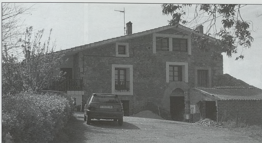
Figura 9. La antigua torre de Las Calzadas (San Vicente de la Barquera) ha experimentado recientes reformas que alteran definitivamente su carácter, pero conserva elementos aislados de gran valor (Fotografía: José Miguel Remolina)
