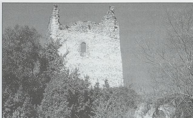
Torre de Estrada, antes de la última restauración
