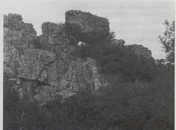
Vista desde el sur, del castillo de Torre Alver.
