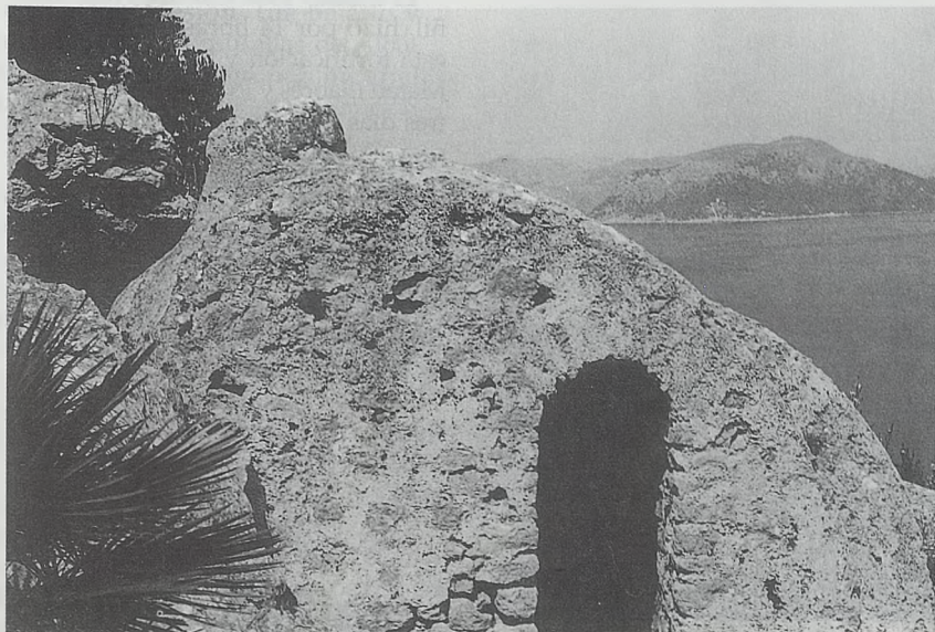
Armario de las municiones. Estado en que se encontraba el 23 de marzo de 1980.
