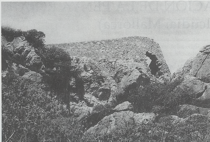
La pared, hoy agujereada, que cerraba el paso.
