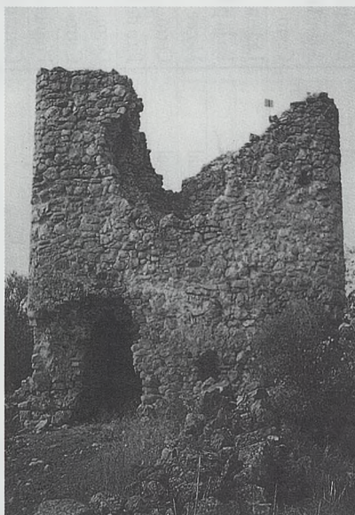
Torreón del «Ero». Fachada sur.
