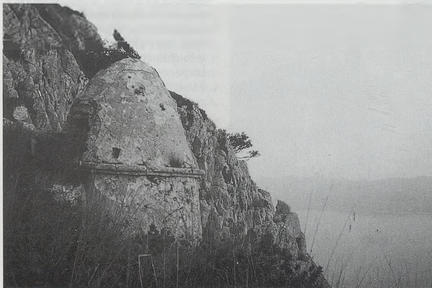
El horno de cocer pan, cerca del aljibe. Al fondo su ve el túnel de acceso.
