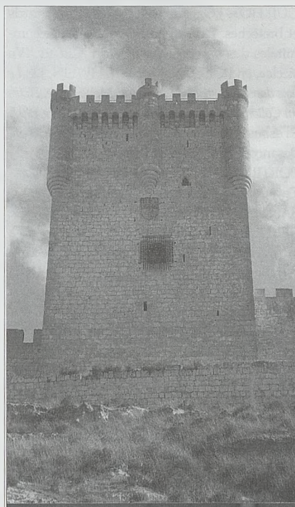
Torre del Homenaje, de planta rectangular de 20 metros de largo por 14 de ancho y 34 de alto, con muros de 3,5 metros de espesor
