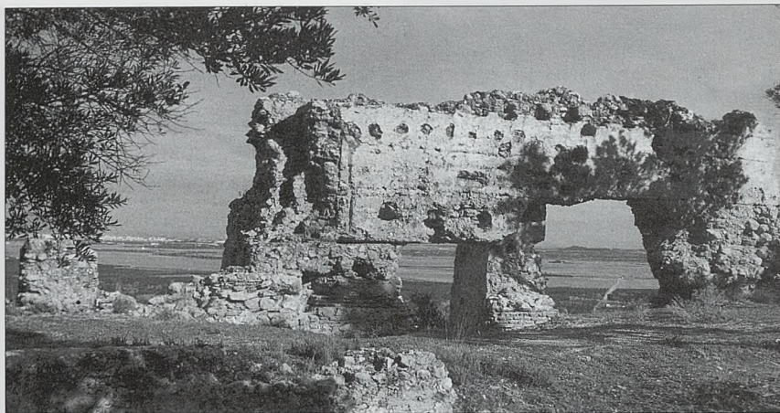
Castillo de Corbera. Celouña: restos del edificio fortificado
