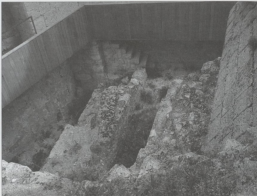
Excavaciones junto a la base de la Torre del Homenaje donde se han encontrado los cimientos de la anterior torre mandada construir por Don Juan Manuel en el año 1307
