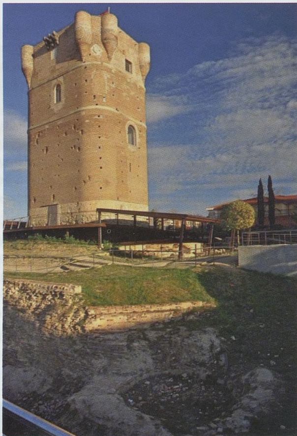
Figura 1: Estado actual del castillo de Arroyomolinos, después de que la arqueología haya descubierto la barrera perimetral y otras dependencias domésticas
