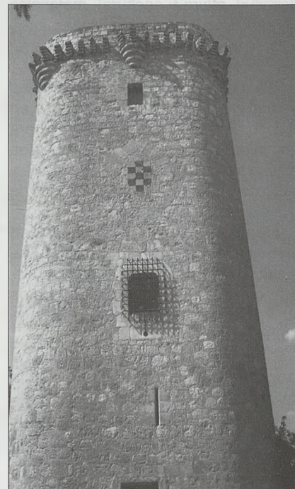
Torre de Pinto, bella torre madrileña en la que destaca su coronamiento y los vanos
