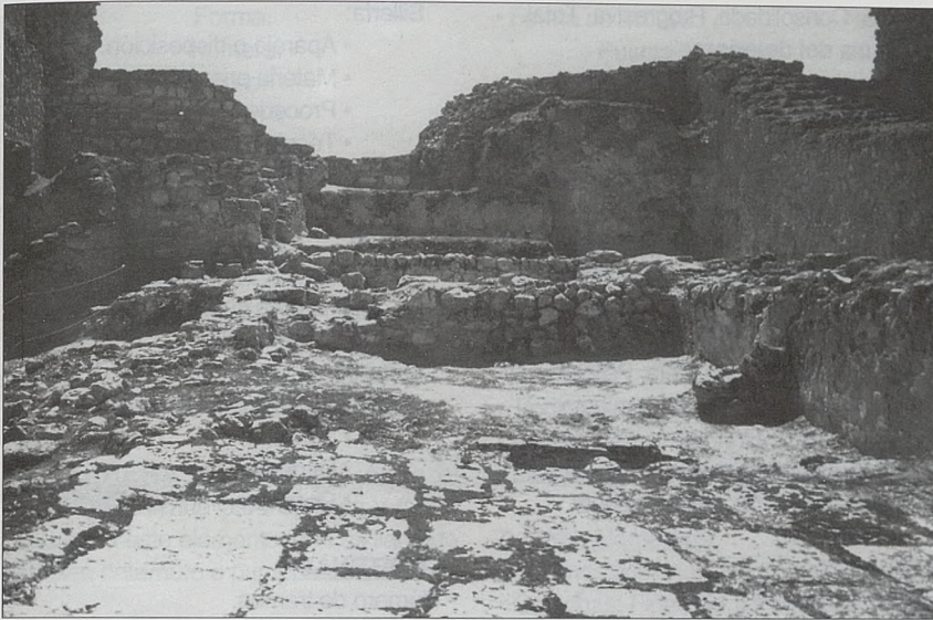
Calatrava La Vieja: interior del alcázar en las excavaciones de 2004
