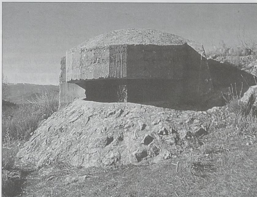
Nido de hormigón nacional con una gruesa losa de blindaje superior cerca de Paredes de Buitrago. La gran tronera de 180° le da gran visibilidad a costa de perder protección
