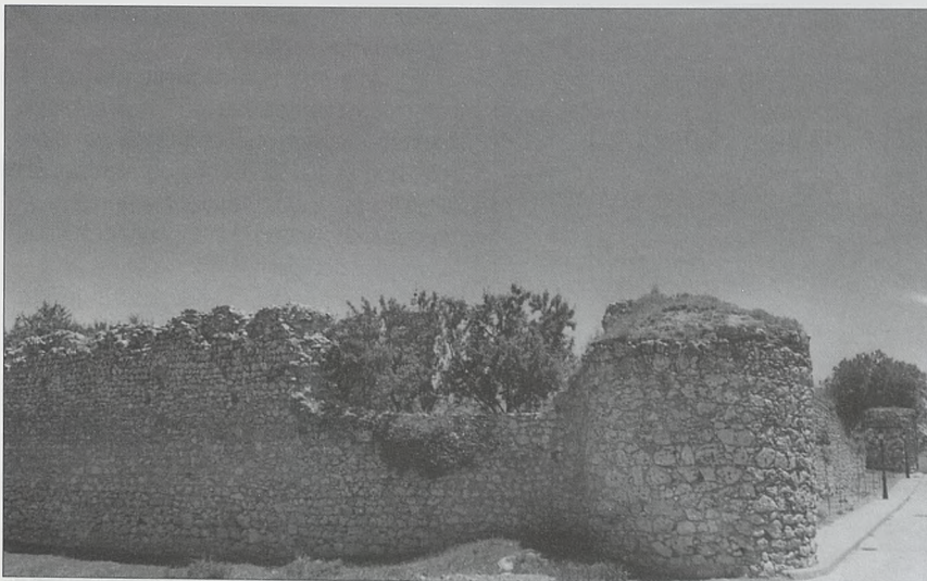
Vista de la torre circular B y parte del lienzo nº 2, mampostería concertada
