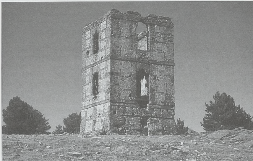
La torre de Monte Redondo, construida en ladrillo y cajas de mampostería
