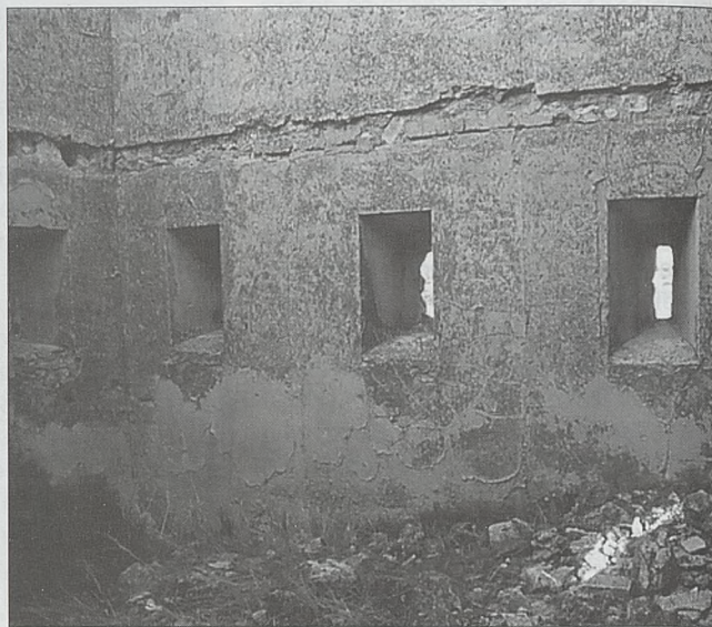
Aspilleras desde el interior de la torre de Perales de Tajuña
