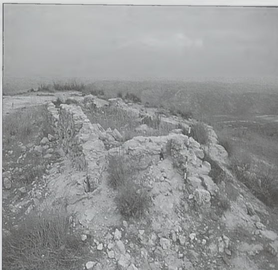
Ruinas cerca del vértice Valdelascasas, dudoso resto de la torre homónima
