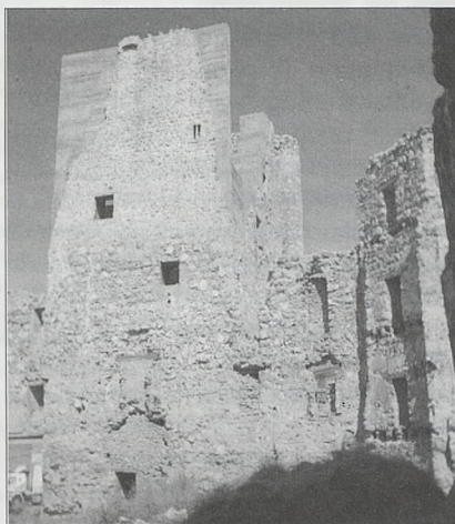
Consolidación de la torre del Homenaje
