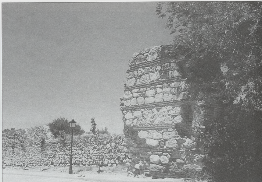
Vista de la torre cuadrada A, realizada en aparejo mixto, y parte del lienzo n.º 1 en mampostería
