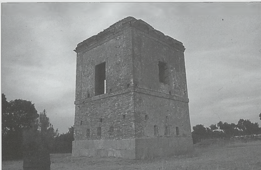
La torre de Tolocirio (Valladolid), nº 13 de la línea de Irún sólo presenta dos pisos, al igual que la nuestra de Aranjuez. Advértase el firme zócalo de sillares de granito
