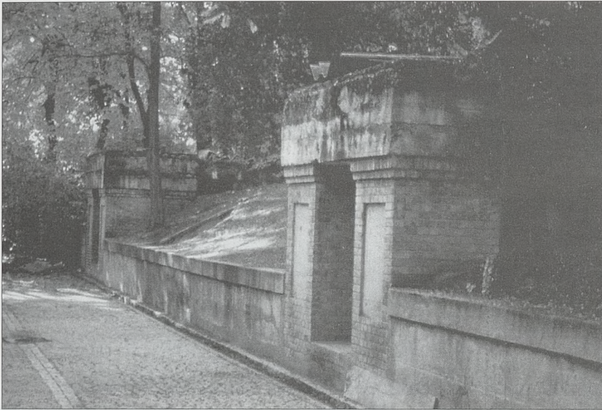
Alameda de Osuna. Entradas al puesto de mando subterráneo (posición Jaca)
