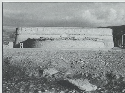
Batería de 4 cañones de Carchuna en Motril (Granada)
