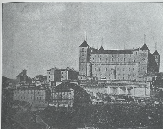
Fachada este en 1888, tras la reconstrucción de 1867, que respetó el anterior aspecto del Alcázar
