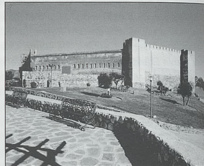
Castillo de Fuengirola (Málaga), con el muro aspillerado construido por los franceses durante la Guerra de la Independencia
