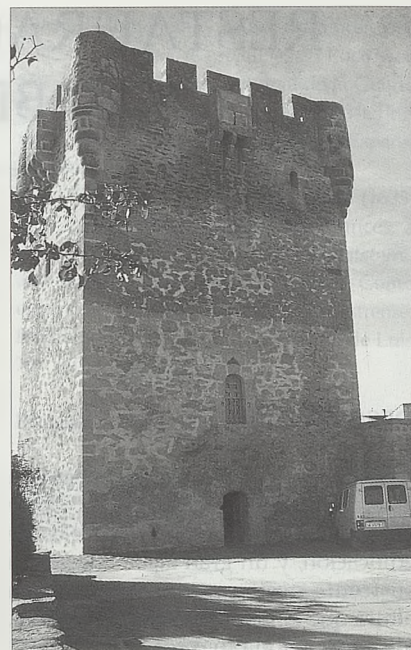
Sobradillo: el frente norte. Se aprecia la entrada y, sobre ella, el vano de la planta intermedia o principal.
