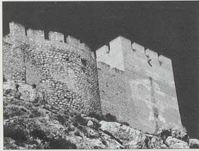
Fotografía 5. Vista de la torre cuadrada de tapial.
