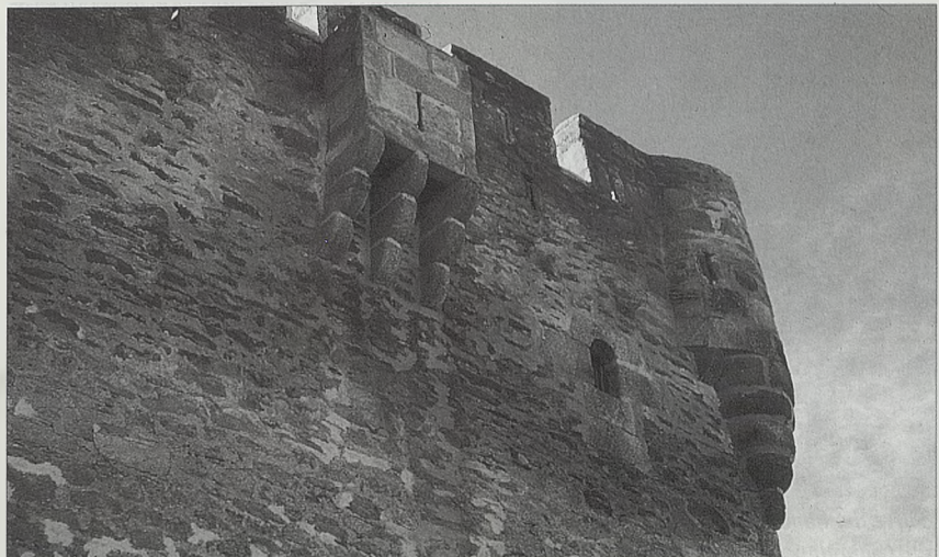
Sobradillo: detalle del almenado, ladronera y garita angular.
