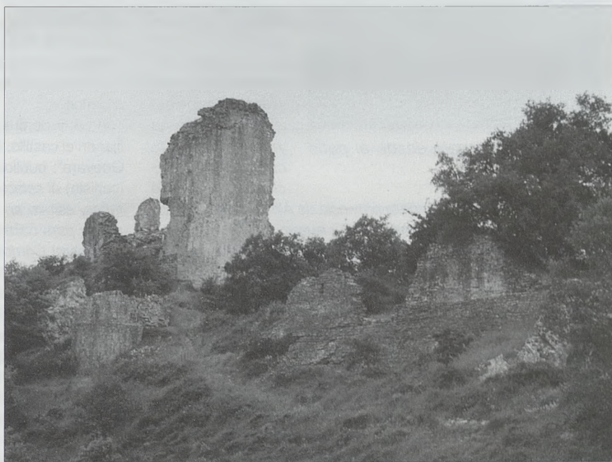
Vista general del castillo de Guevara. Fotografías del autor
