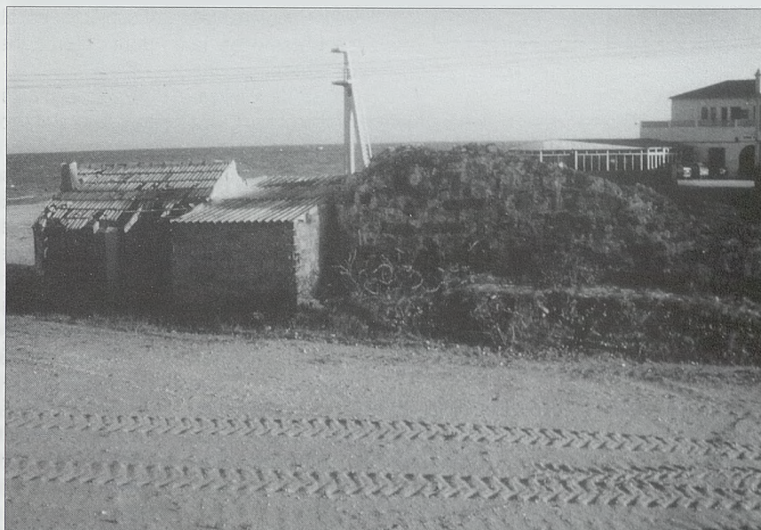
Conjunto de los restos de la Torre de Pinet (Elche) desde el norte, con las dos estructuras adosadas posteriormente
