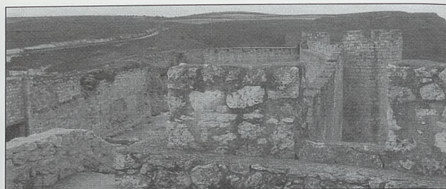
Vista de las almenas superiores, formando un pasillo que recorre todo el perímetro del castillo
