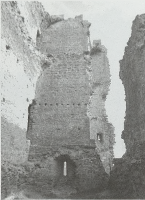
Fig. 11 Paredón sur desde el interior (Autor)
