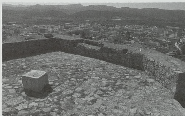
Planta de cañoneras en la batería del Este
