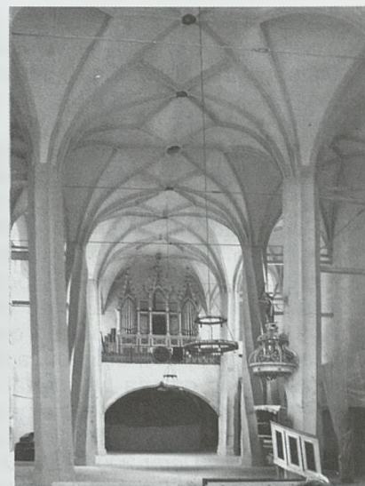
Interior de la iglesia de Mosna
