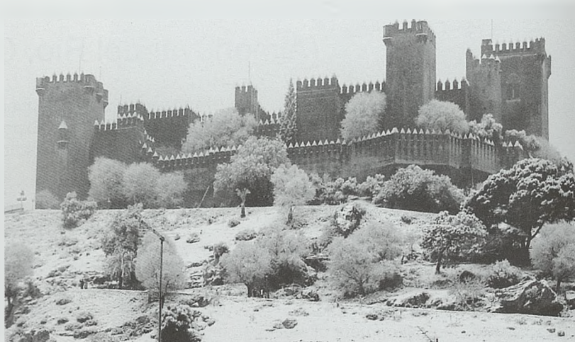
Frente noroeste del castillo tras la nevada, muy raras en Córdoba, de enero de 2006. En el extremo izquierdo puede verse la torre del homenaje, Albarrana de 33 m. de altura. Y en el extremo derecho la torre Escuela, de 27 m. de altura.
