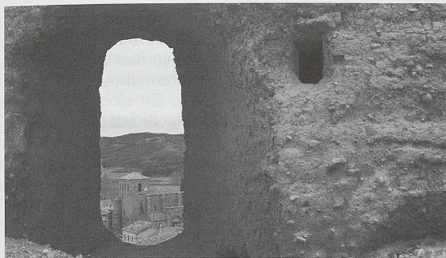
Figura 9. Hueco en el muro norte por la que se divisaba la población de Serón que se extiende a los pies del castillo y el valle del río Nágima que comunica Monteagudo de las Vicarías con Gómara
