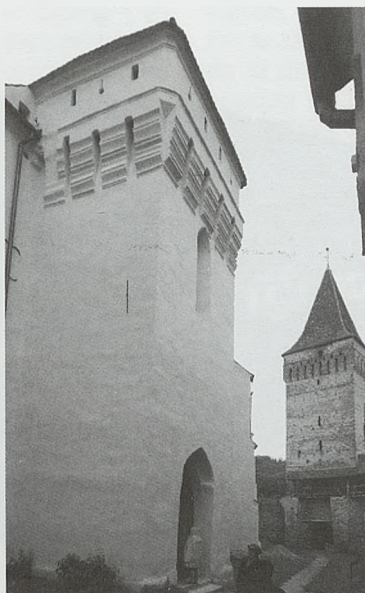
En primer término, torre meridional de ingreso a la iglesia de Mosna, con remate amatacanado, y al fondo, torre de la puerta principal
