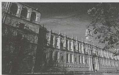
San Marcos. Fachada principal
