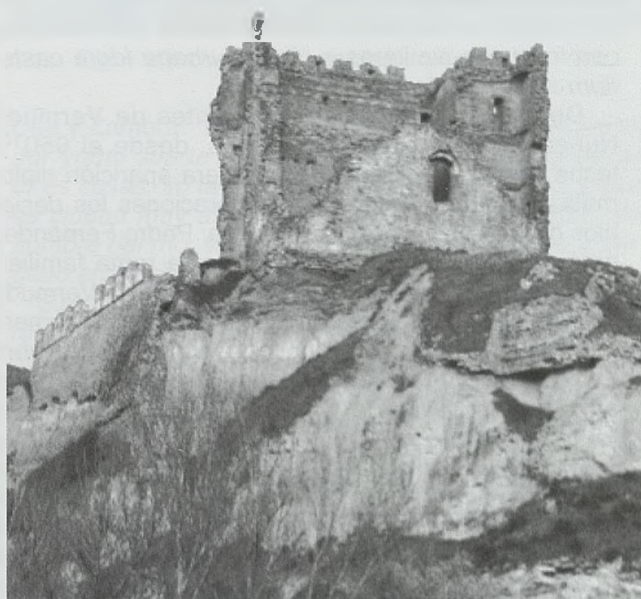
Fig. 6 Vista de la fábrica del castillo, abalconada por los derrumbes del cerro (Autor)
