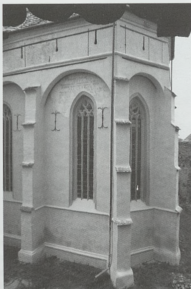
Cabecera de la iglesia de Mosna con arcos paralelos a los muros entre estribos y piso defensivo superior en el que se abren ladroneras rasgadas
