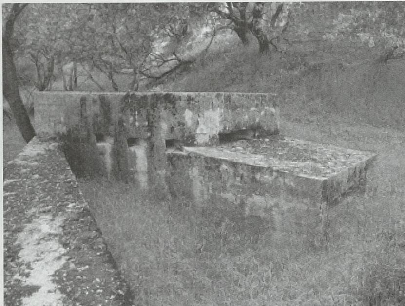
Casamata y muro anticarro en el elemento de resistencia del Perales (Quijorna)
