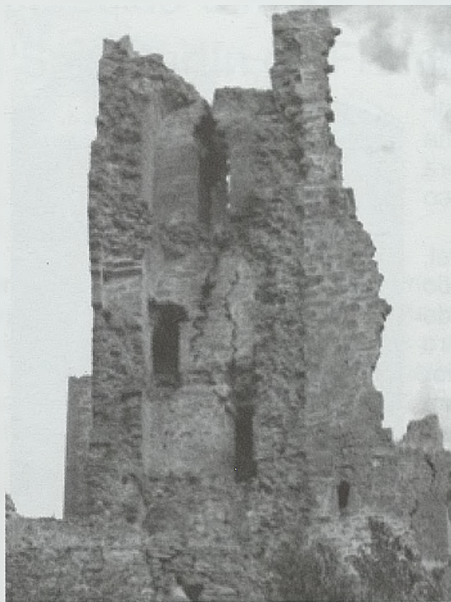
Fig. 9 Vista del paredón norte desde el exterior, al borde del desplome (Autor)
