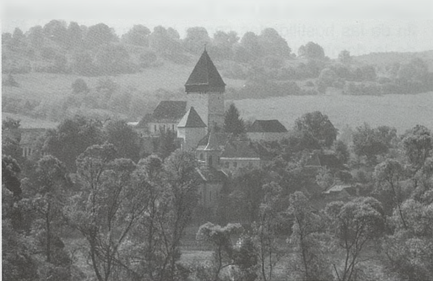
La iglesia fortificada de Hosman está situada en la parte alta de la población. Vista desde el noroeste
