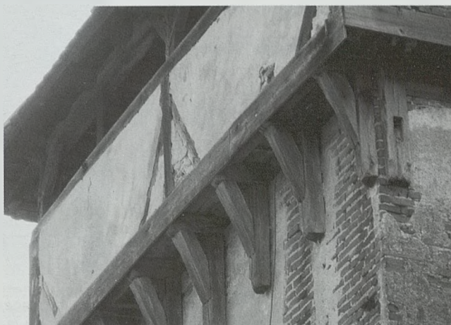
Detalle de los jabalcones que sostienen la estructura lignaria del cadalso de la iglesia de Pelisor
