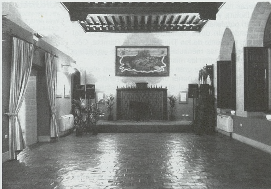
Es un amplio espacio diáfano de 12,5 m de largo, 7 m de ancho y 5 m de alto. Las vigas del techo son de madera de pino de tea. Tienen función exclusivamente decorativa ya que e techo de la Biblioteca posee –por expreso deseo de Torralva– una de las estructuras más resistentes del castillo
