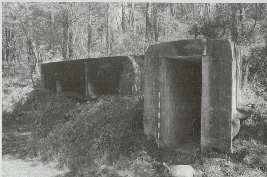
Puesto de mando blindado de la posición «Loma Verde» (Puentes Viejas)
