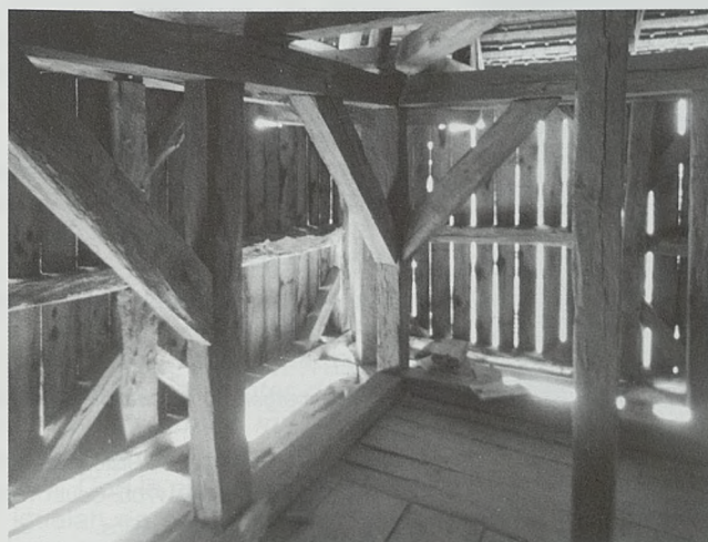
Vista interior del cadalso de madera de la torre Hosman
