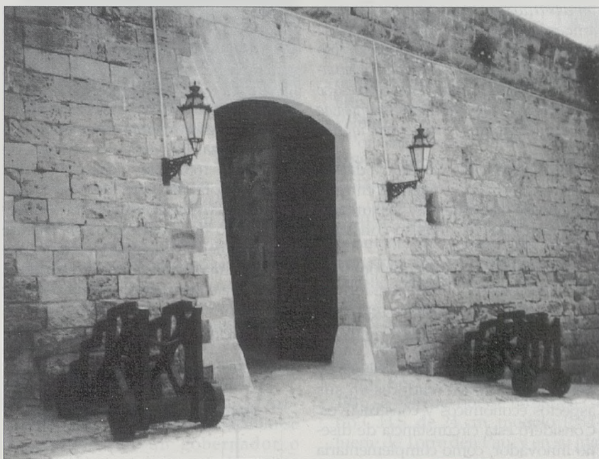
Acceso actual practicado con la reforma de 1890.
