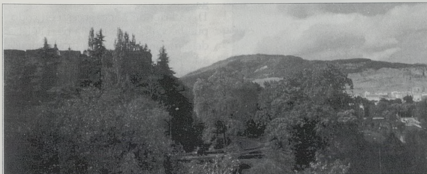
Vista del monte San Cristóbal desde las murallas abaluartadas de Pamplona. El fuerte se encuentra perfectamente camuflado en la cima del monte.
