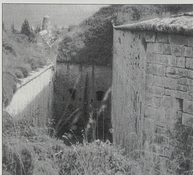
Vista parcial de la caponera del oeste.
