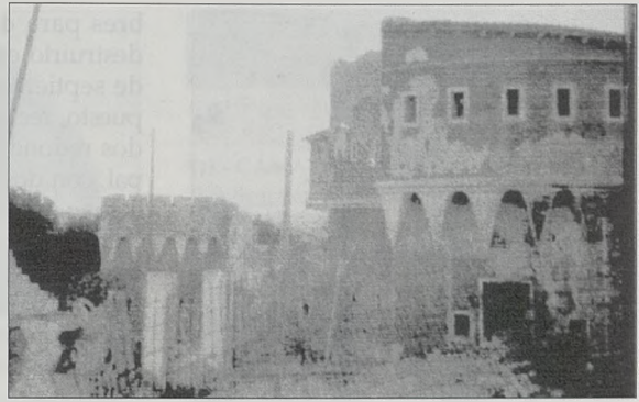
Fuerte M.ª Cristina: acondicionamiento en 2002.
