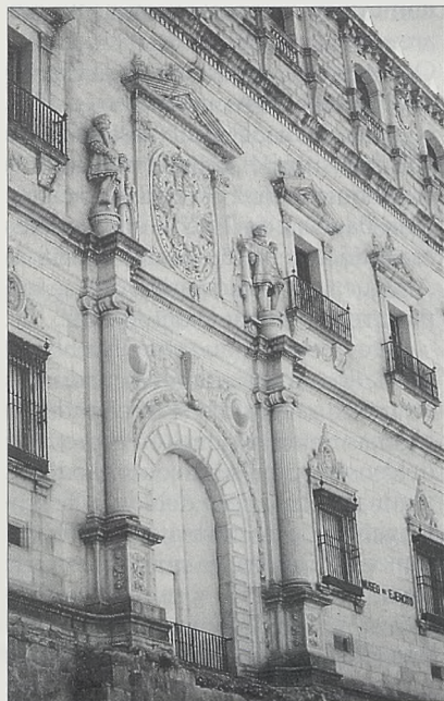
Detalle de la portada de la fachada norte. El escudo imperial está guardado por dos reyes de armas.
