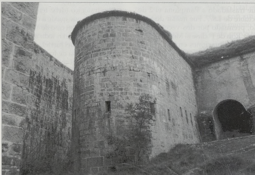
Semicaponera en el foso de flanqueo sur, flanqueada por su derecha con un orejón acasamatado, que cubre el acceso al foso tansitable.
