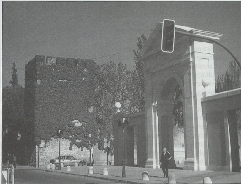
Puerta de Madrid y parte del recinto fortificado del palacio Arzobispal
