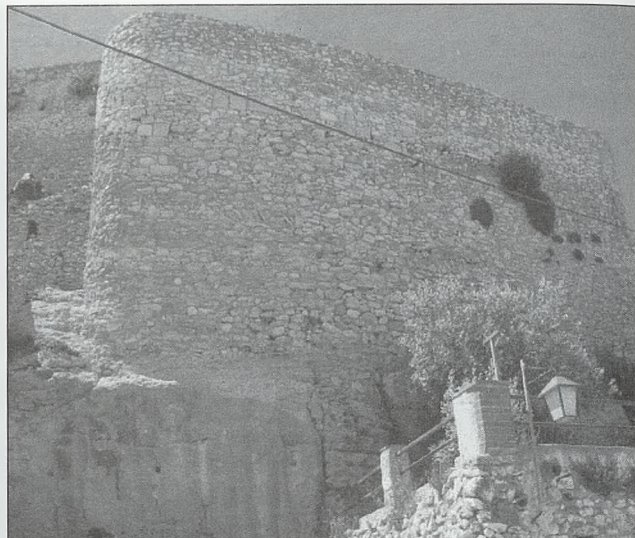
Fig. 17. Refuerzo construido a principios del siglo XVIII para recomponer el lienzo sur de la muralla volado hacia la mitad del siglo anterior
