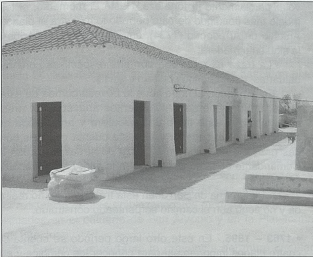
Aljibe y parte trasera de la casa del Gobernador. Año 2005
