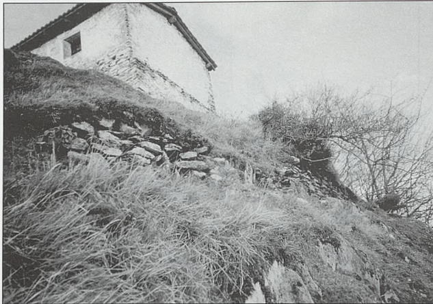
Gorriti. Restos de muros bajo la ermita (año 1999)
