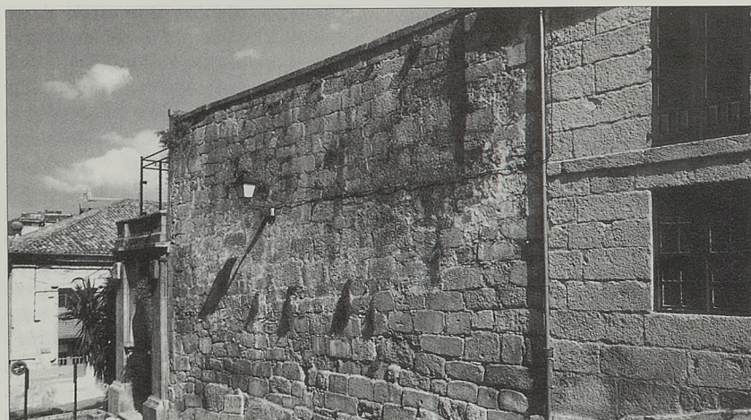
Fig. 8. Palacio episcopal de Ourense. Restos de la torre suroeste.
