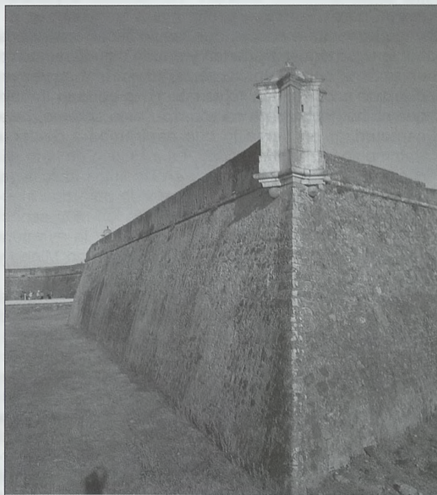
Garita de un fuerte exterior de Elvas
