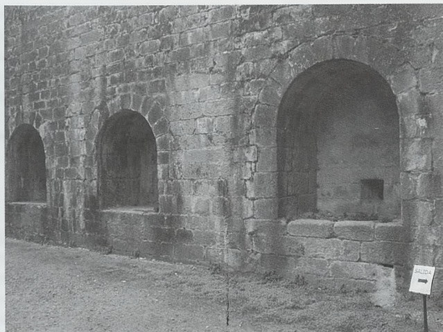
Foto 6. Troneras de la barrera de Puebla de Sanabria
