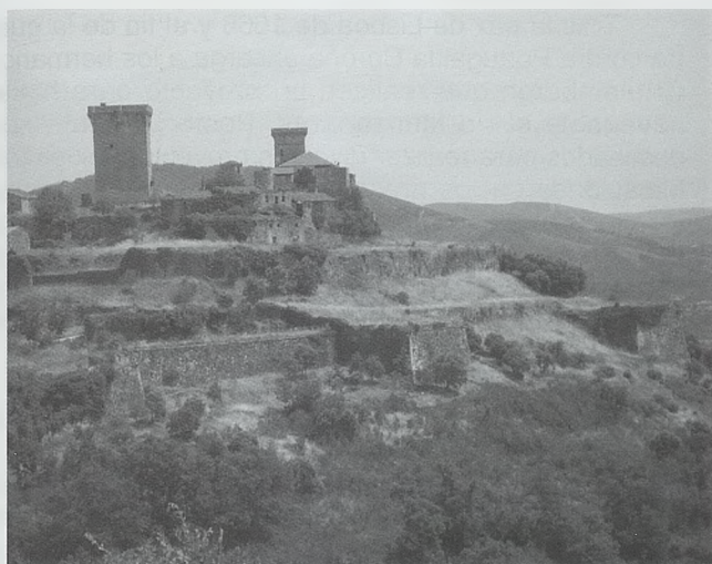
Foto 10. El hornabeque: con el baluarte central y el semibaluarte contruido
