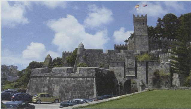
Fortaleza de Monterreal, Baiona
