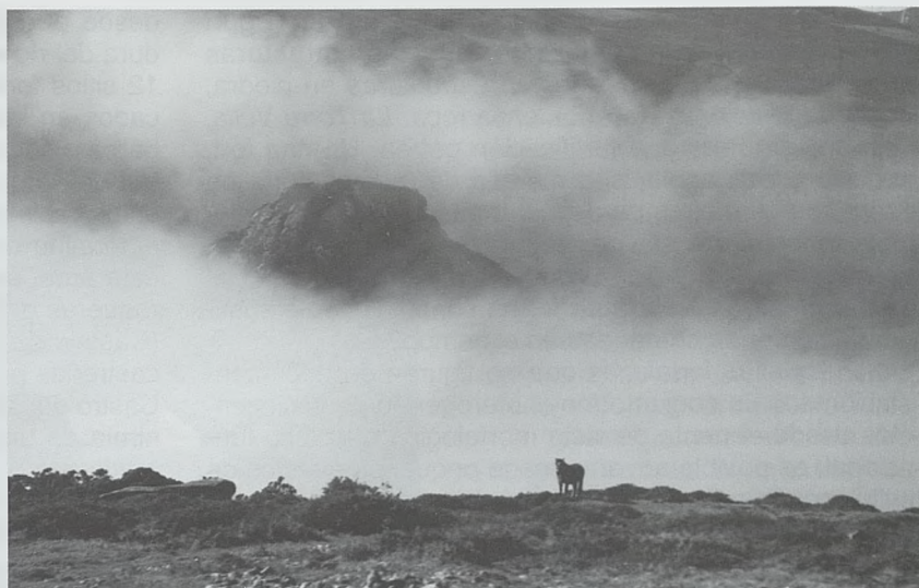
Castillo de control viario. Castelo de Vilacampa (O Valadouro, Lugo) Foto: Manuel Miranda
