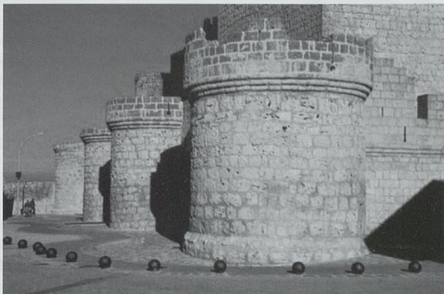
Cubos de la barrera de Portillo
