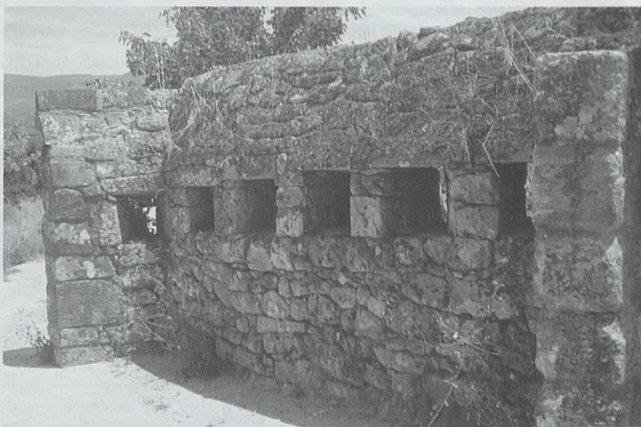
Foto 14. Corredor aspillerado en los laterales y frontal con doble entrada y adosado al muro de la falsabraga en la zona de la Puerta de San Francisco
