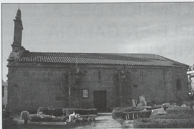
Vista exterior de la iglesia románica de Santa María do Temple (Cambre, A Coruña)
