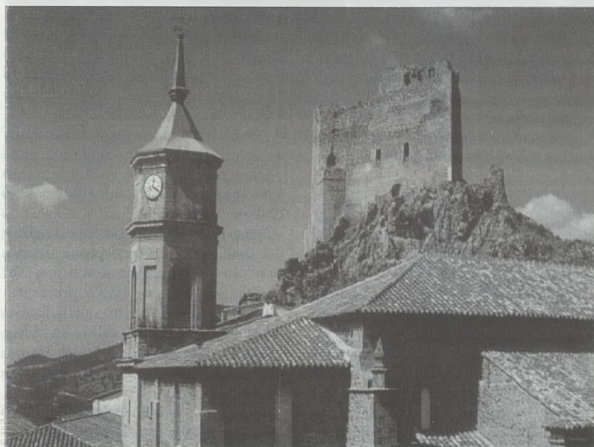
La fortaleza de Alcalá de la Selva
