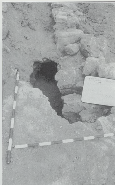
Bóveda subterránea. Zona con techumbre hundida.
