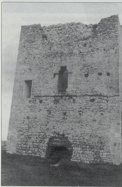
Torre del Homenaje del castillo de Calatañazor, en la que se distingue su construcción de sillarejo y mampostería.
