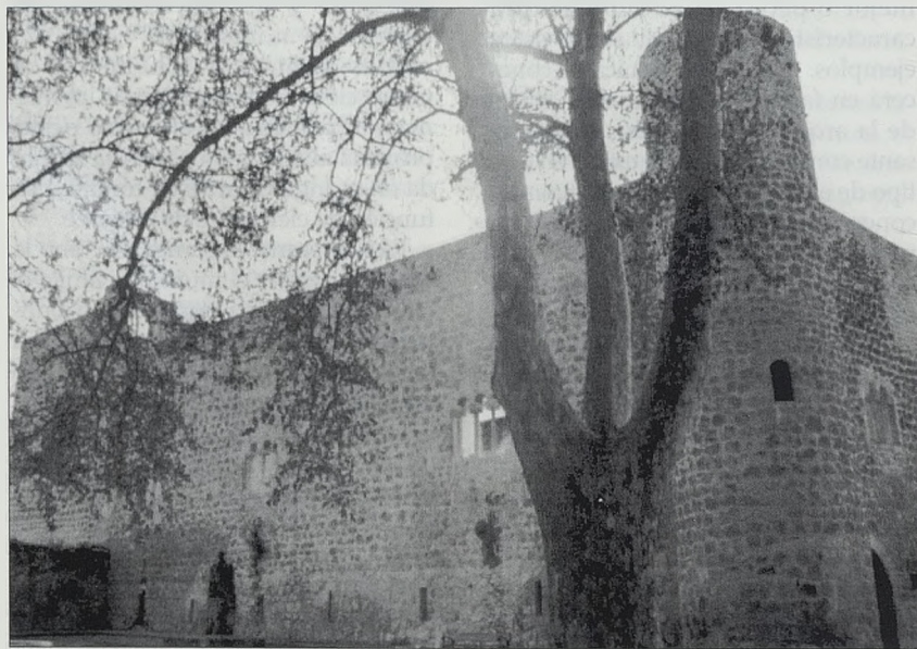
Crujía norte al exterior.
