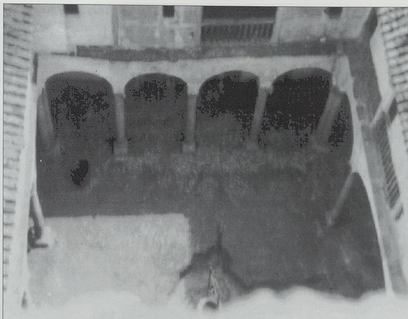
Estado del patio del castillo de Batres antes de su restauración.
