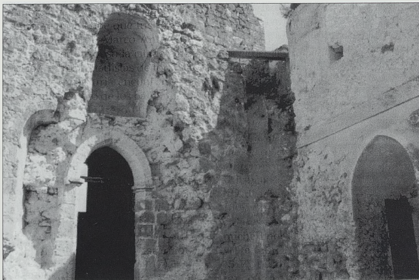
Ángulo de encuentro de la torre del Homenaje (izqda.) con el recinto original.
