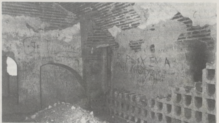
Lám. 9. Vista interior de los paramentos O. y N.
