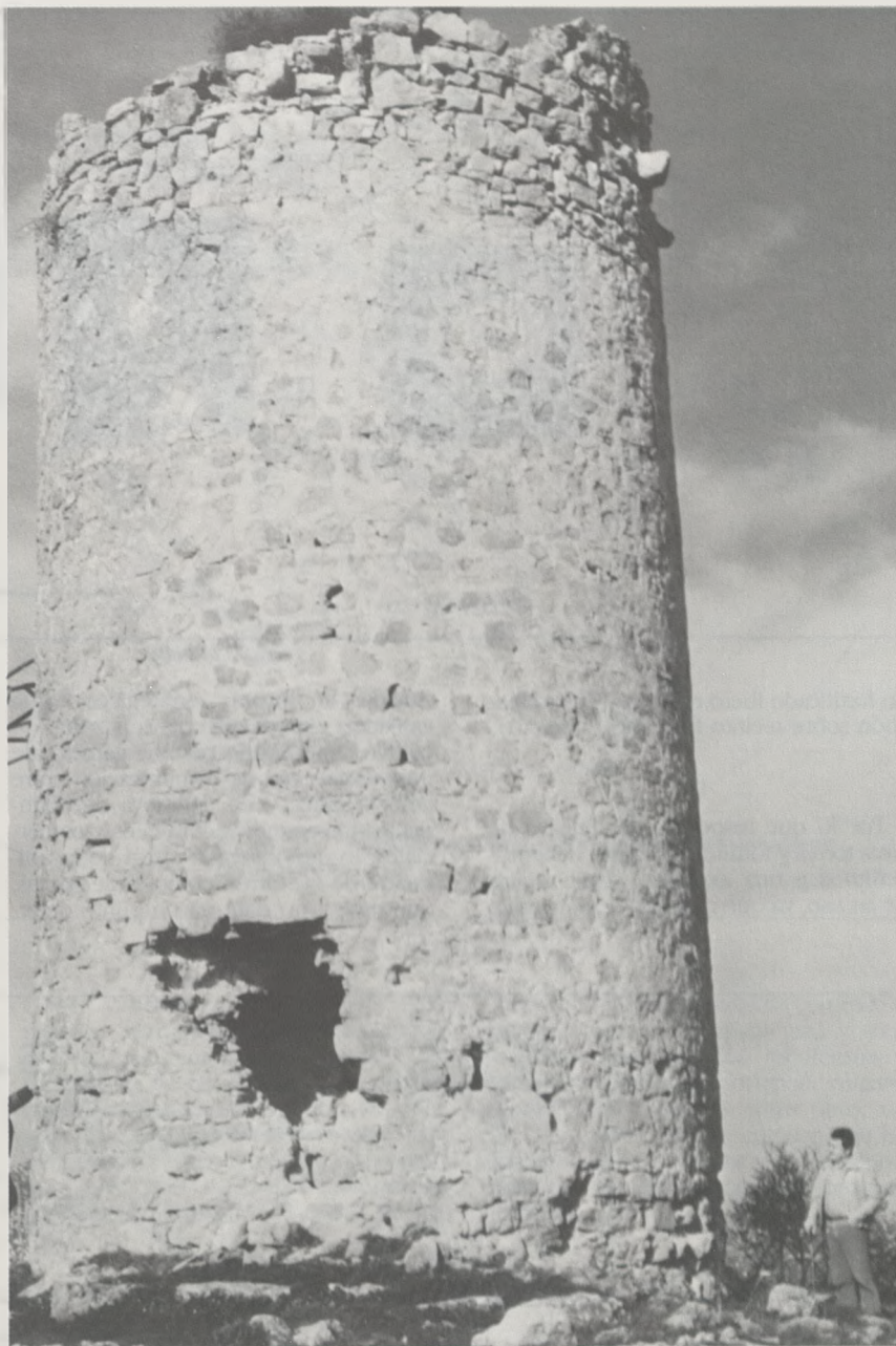
Vista E del Torreón del Mochón, situado en el Marquesado de Priego.
