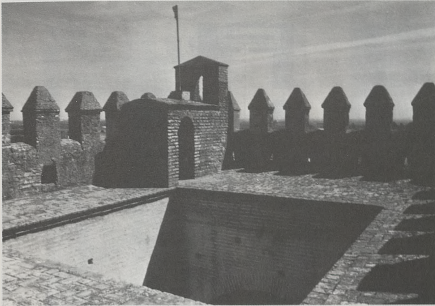
Vista de la planta de adarves y el almenado.
