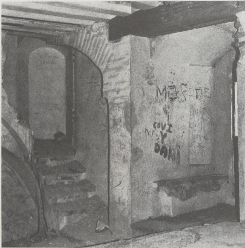
Lám. 8. Vista interior de la escalera E: 3-4 y el hueco 3/H 1.
