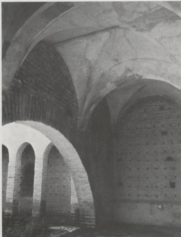
Detalle de las bóvedas de los costados mayores de la tercera planta.
