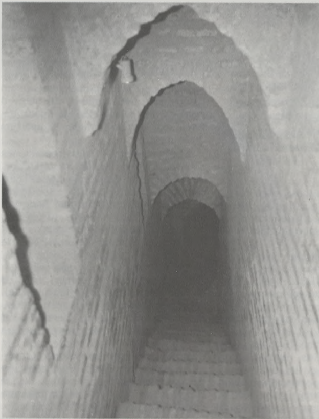
Vista de las escaleras y descansillo.
