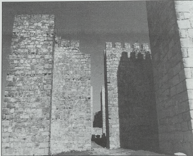
Torre albarrana. Trujillo. Cáceres
